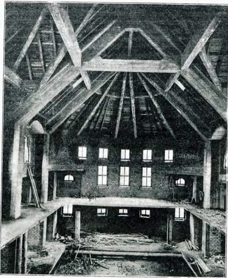
Rys. 6. Wiązary z rys. 4 po rozszalowaniu.
