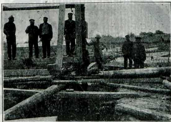
Budowa nowej odlewni stali w Zakładach Briańskich. Wykonanie fundamentów palowych syst. „Sterna”.
