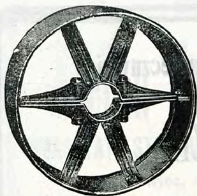
Fairbanks koła pasowe z blachy stalowej. Niezrównane pod względem wytrzymałości, lekkości, dokładności wykonania i rozmaitych wymiarów. Najłatwiejszy montaż bez klinów.
