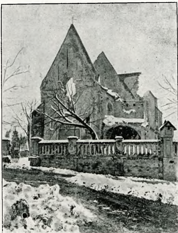
RADŁÓW — kościół gotycki po zniszczeniu
