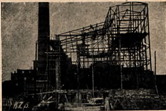
Fragment konstrukcji żelaznej wykonanej w elektrowni Cukrowni w Szamotulach.
