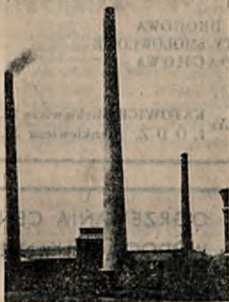
Kompletna budowa komina wysokości 105 m. x 3,50 średnicy dla Grodzieckiego Towarzystwa Kopalń w Grodźcu.
