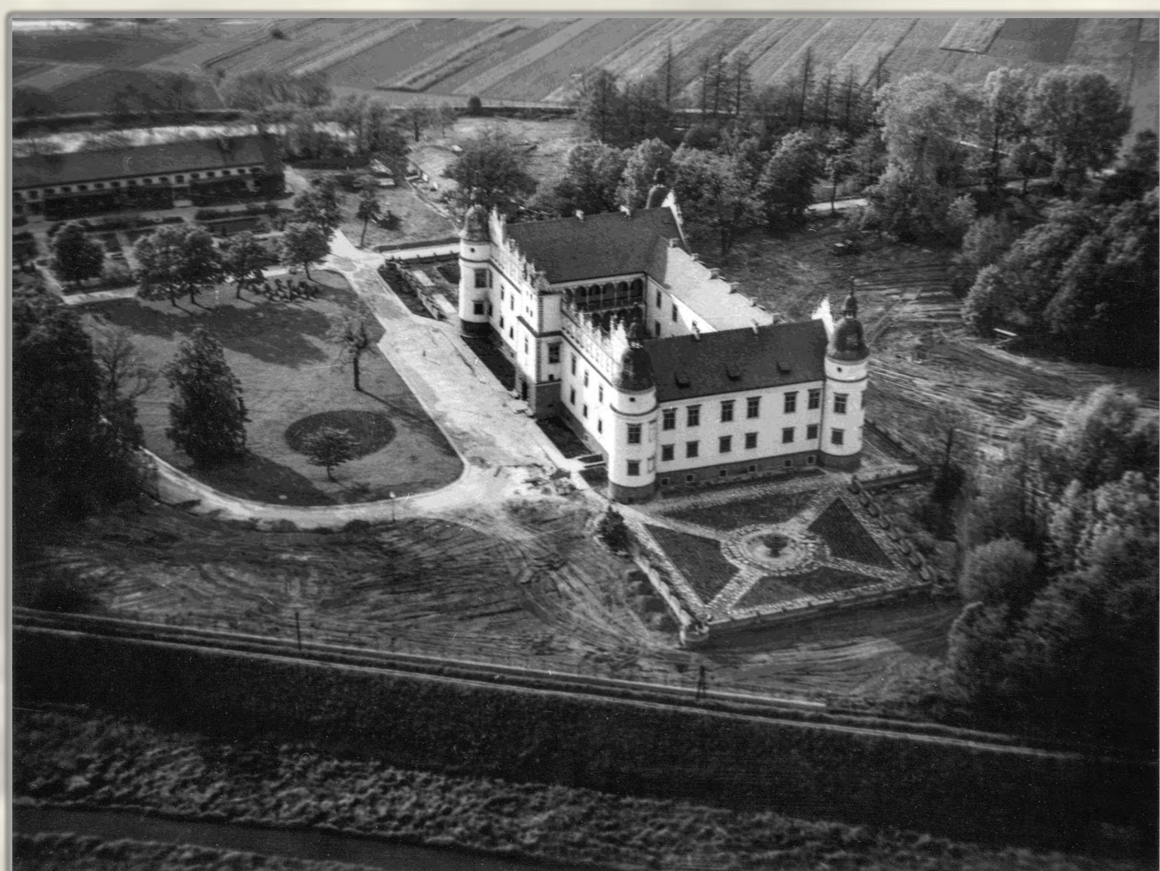
Zamek w Baranowie Sandomierskim. Fot. Z. Siemaszko
