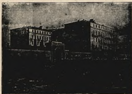
Fragment Ofic. Szkoły Inżyn. Budowa wykonana przez firmę „Żelazo-Beton“.
