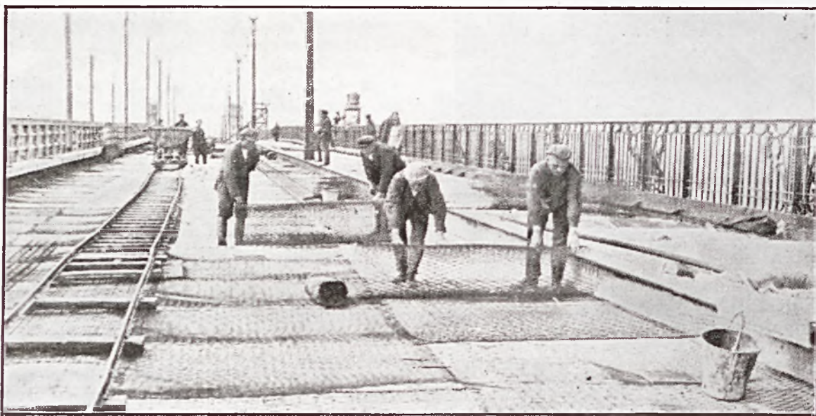
Zbrojenie podłoża betonowego na moście Ks. Ponia-towskiego w Warszawie siatką jednolitą „Métal Déployé“.
