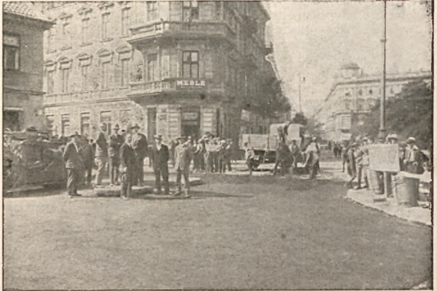
Układanie dolnej warstwy asfaltu walcowanego jezdni na placu Trzech Krzyży.
