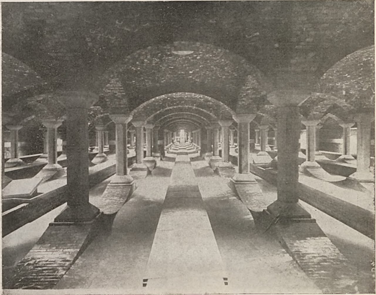
Filtr wodociągowy, przed załadowaniem piaskowem.
