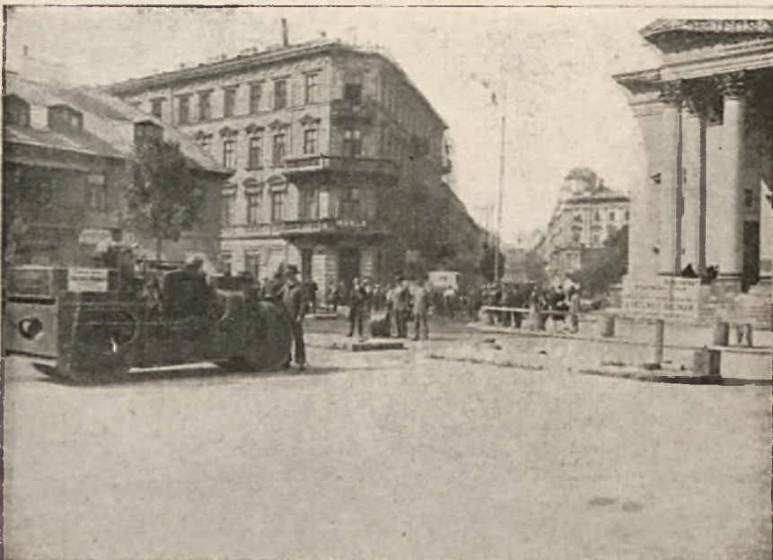
Walcowanie wierzchniej warstwy i wykończona część jezdni na placu Trzech Krzyży.
