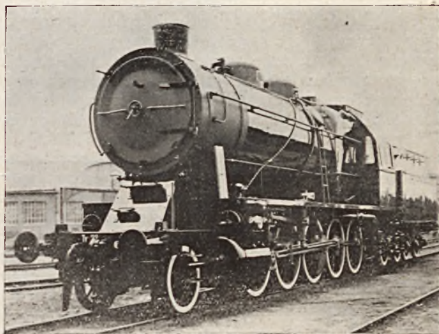
Parowóz towarowy serji Ty 23. budowy Tow. Akc. H. Cegielski w Poznaniu.
