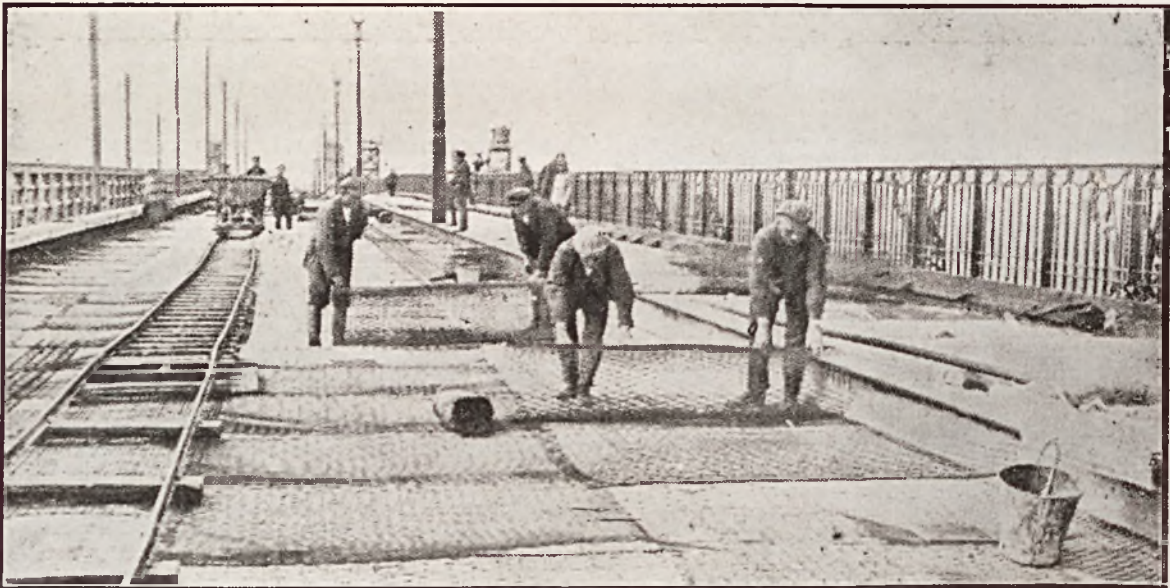
Zbrojenie podłoża betonowego na moście Ks. Ponia-towskiego w Warszawie siatką jednolitą „Métal Déployé“.
