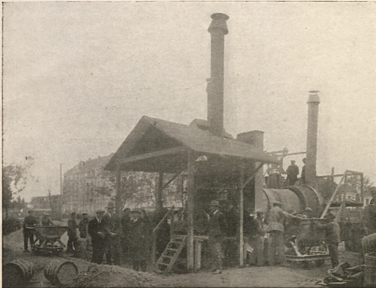
Parowa maszyna marki Warrens, produkująca mieszaninę masy do budowy jezdni.
