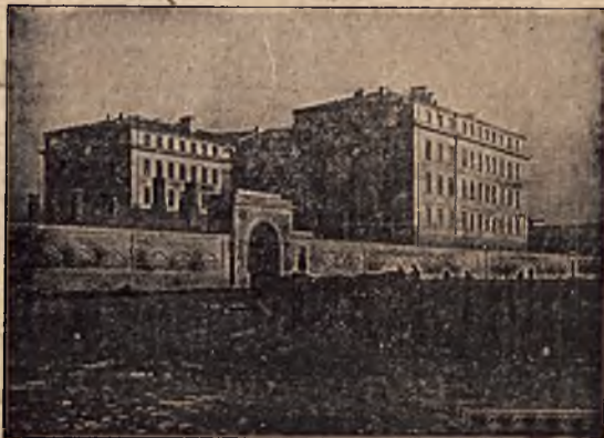
Fragment Ofic. Szkoły Inżyn. Budowa wykonana przez firmę „Żelazo-Beton“.
