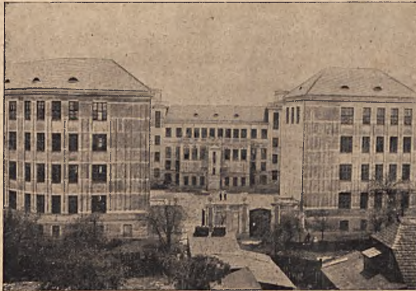
Warszawa, Szkoła powszechna przy ulicy Bema, wyk. przez Stołeczne T-wo Budowlane.
