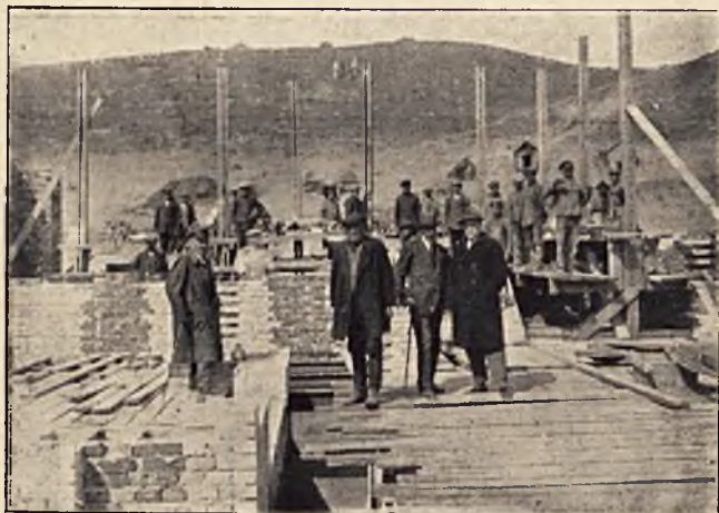
GDYNIA. Budowa domów mieszkalnych Marynarki Wojennej. Wykonywa przy pomocy rusztowań ruchomych firma „Żelazo - Beton”.
