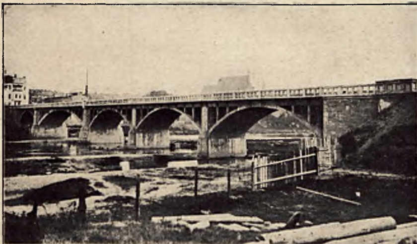
Most żelazo-betonowy na Sole pod Oświęcimm, zbudowany z portland - cementu cementowni „Szczakowa”, według projektu i pod kierownictwem inż. Markiewicza.
