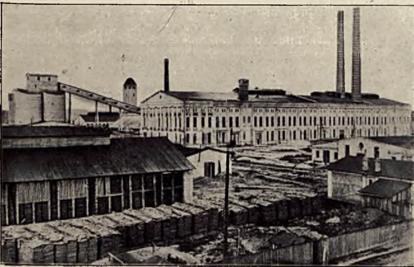
Widok ogólny cementowni „Wysoka” przy stacji kolei żelaznej w Rosi.
