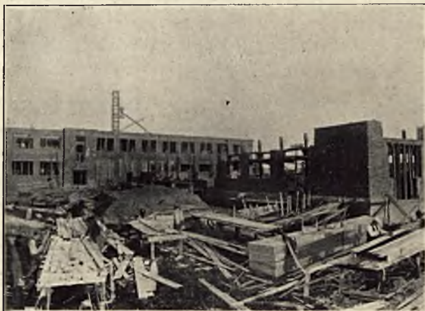
Budowa fabryki włókienniczej, wznoszona przy pomocy ruchomych rusztowań.
