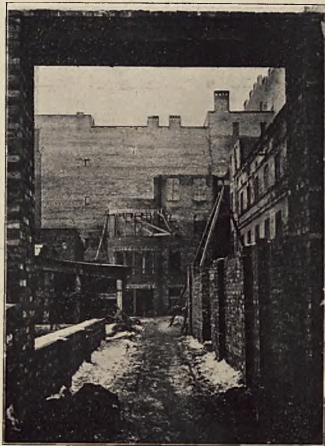
ŁÓDŹ. Budowa domu mieszkalnego I. Tyllera przy ul. Narutowicza 51.
