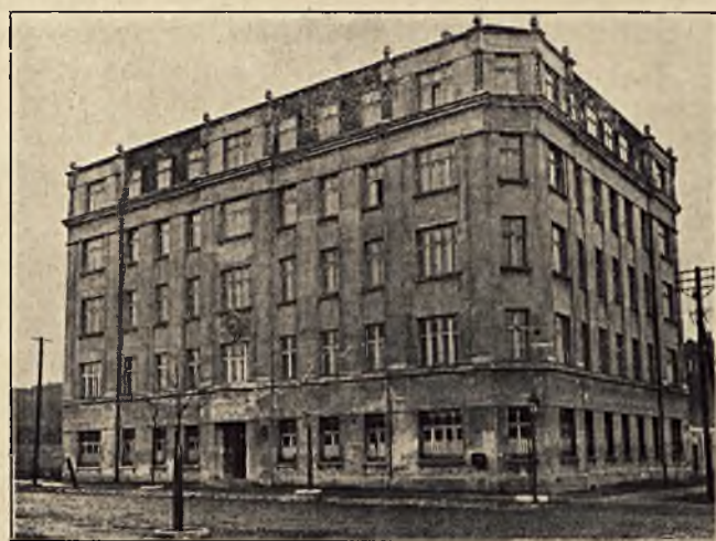
ŁÓDŹ. Dom mieszkalny I. Tyllera przy ul. Narutowicza 71.
