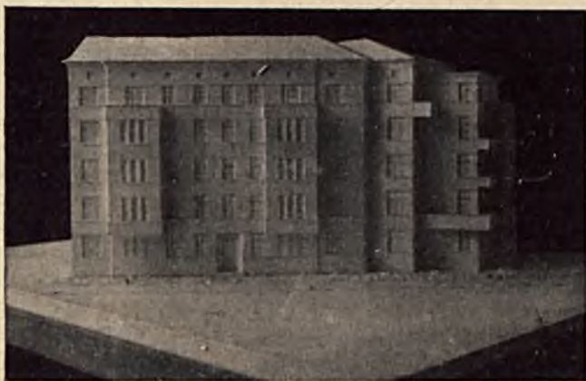
ŁÓDŹ. Projekt domu narożnego f-my I. Fuks i S-ka, w perspektywie od ul. Trębackiej. Budowę wykonywa prezs. bud. I. Tyller.
