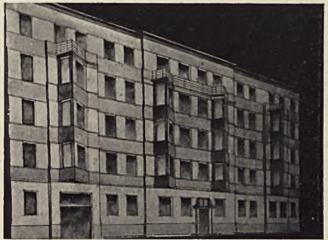
ŁÓDŹ. Dom f-my Fuks i S-ka przy ul. Cegielnianej 95. Budowę wykonywa przeds. bud. I. Tyller.
