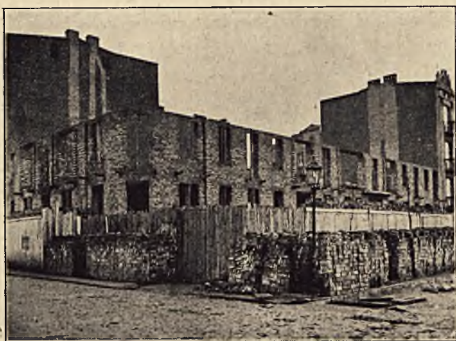
ŁÓDŹ. Budowa domu mieszkalnego I. Tyllera u zbiegu ul. Cegielnianej i pl. Dąbrowskiego.
