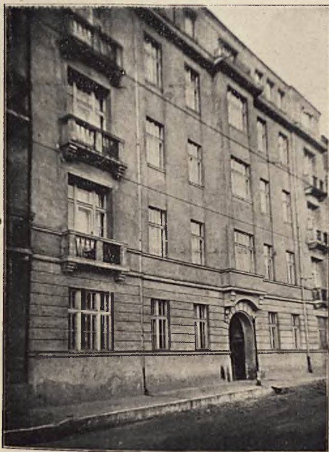
ŁÓDŹ. Dom mieszkalny I. Tyllera przy ul. Zielonej 63.
