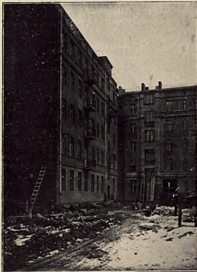
ŁÓDŹ. Kamienica czynszowa I. Tyllera przy ul. Tramwajowej (widok od podwórza).
