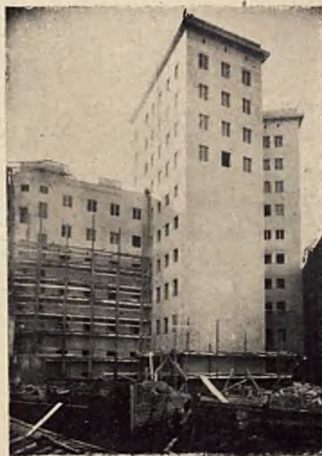
Fasada wieży gmachu Polskiej Dyrekcji Ubezpieczeń Wzajemnych w Warszawie, ul. Kopernika 34, wykonana „Terraboną”.
