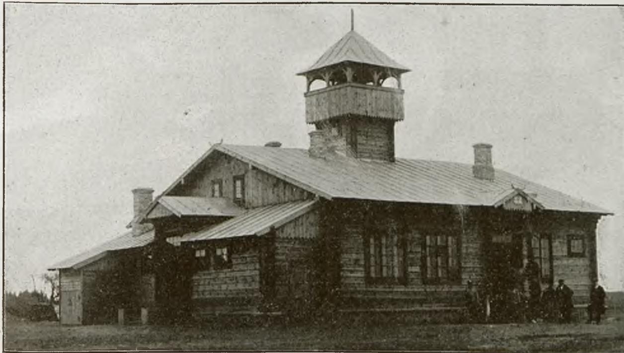
Jedna z dziewięciu strażnic na pograniczu z Bolszewją, wybudowanych w ciągu 3 miesięcy w porze zimowej (przez Stoleczne tow. budowlane inż. A. Ponikowski i E. Ostrowski w Warszawie.)
