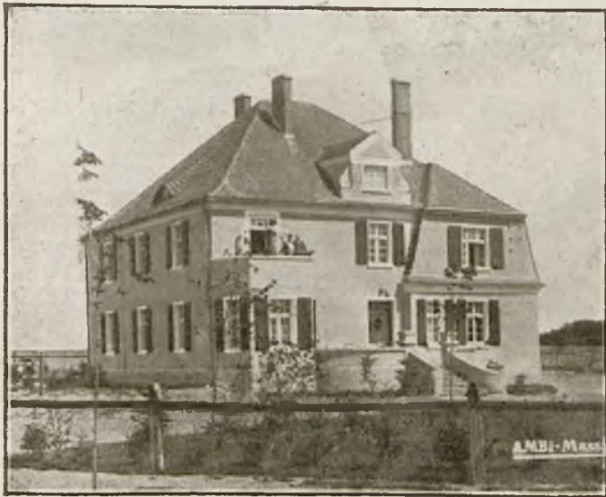
BUDOWA SYST. AMBI. Zamek w Ernstlof. Niemcy.
