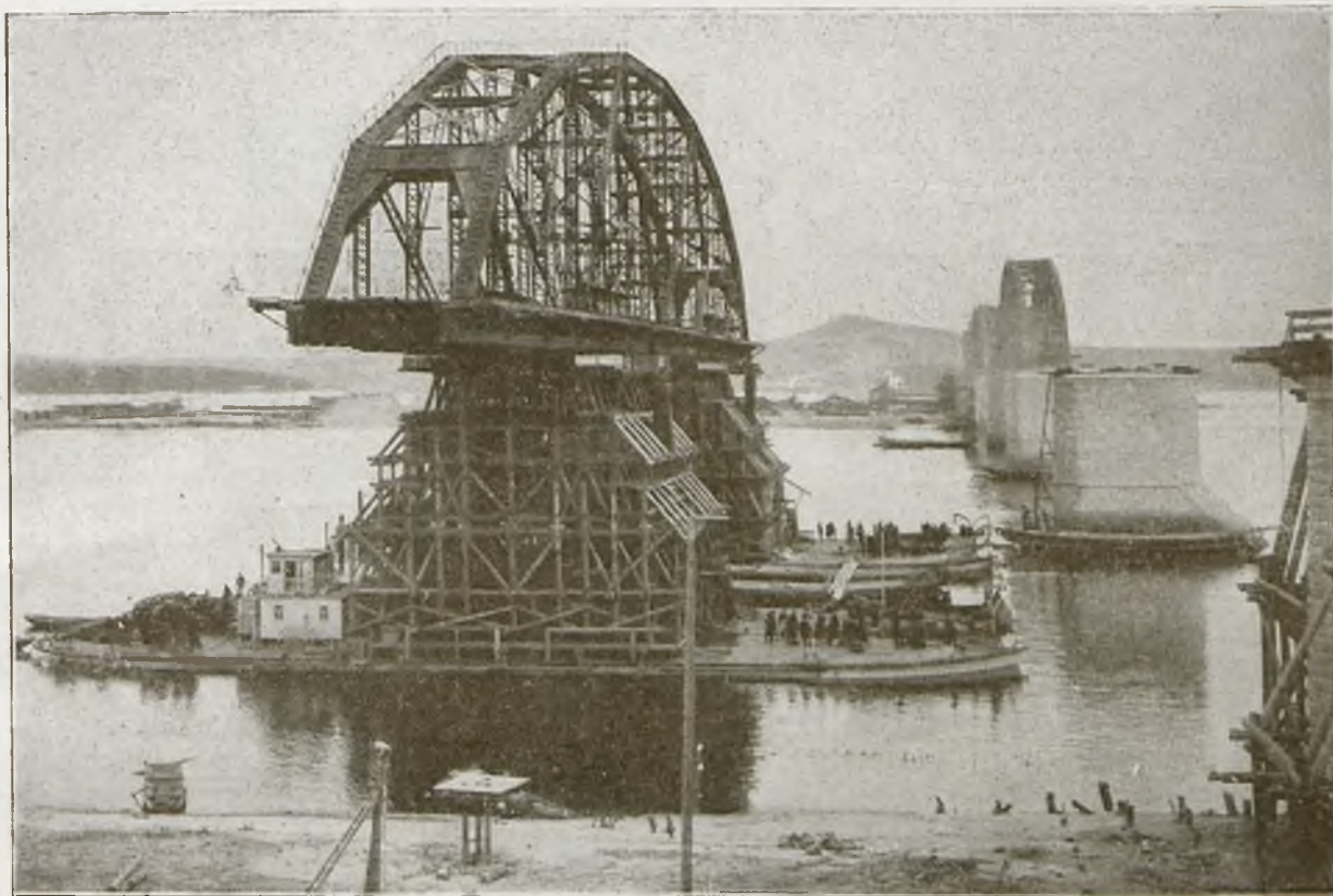
Przewożenie przesł mostu przez rzekę Amur.
