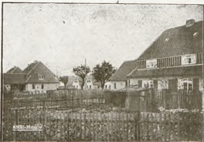
BUDOWA SYST. AMBI. Osiedle w Niemczech (Teuchern).
