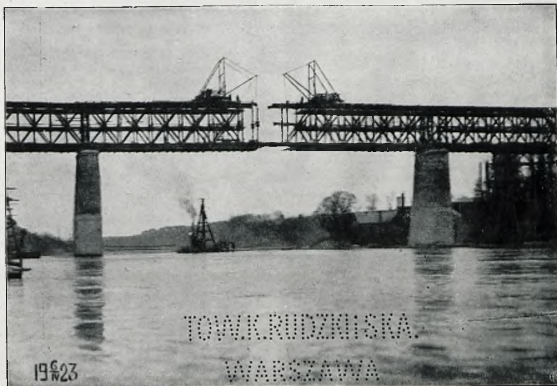
Most na Niemnie pod Grodnem w czasie budowy (bez rusztowania).
