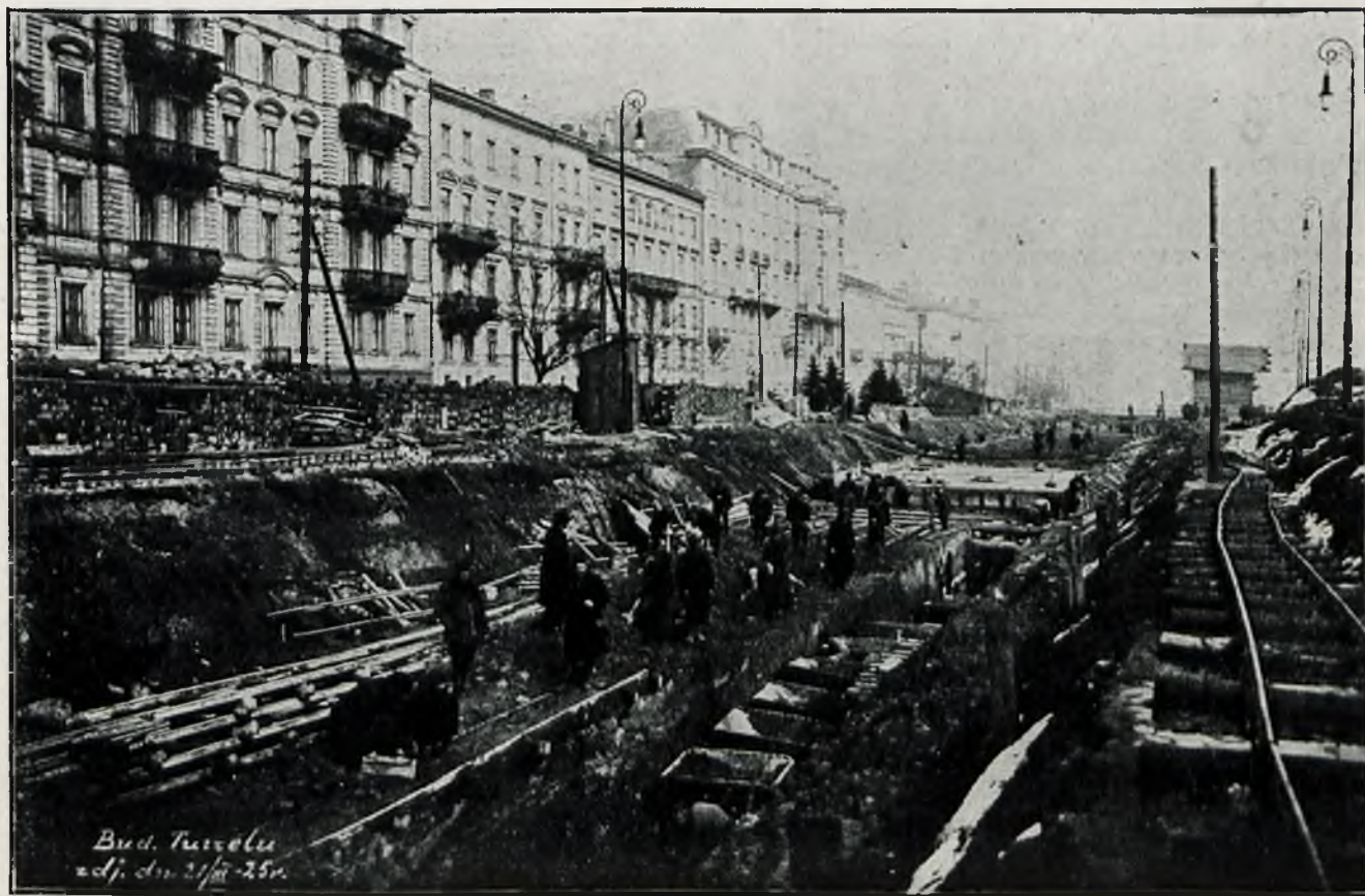
Roboty w tunelu w Al. 3 Maja (Widok ogólny).
