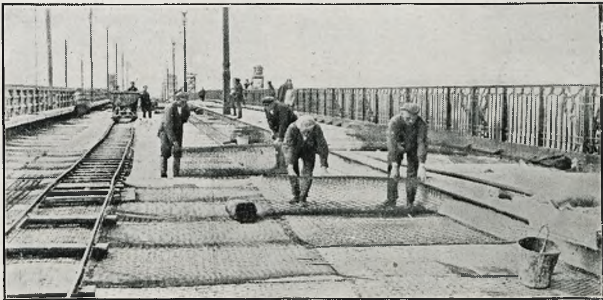
Układanie siatki z t. zw. metalu „deploye“.
