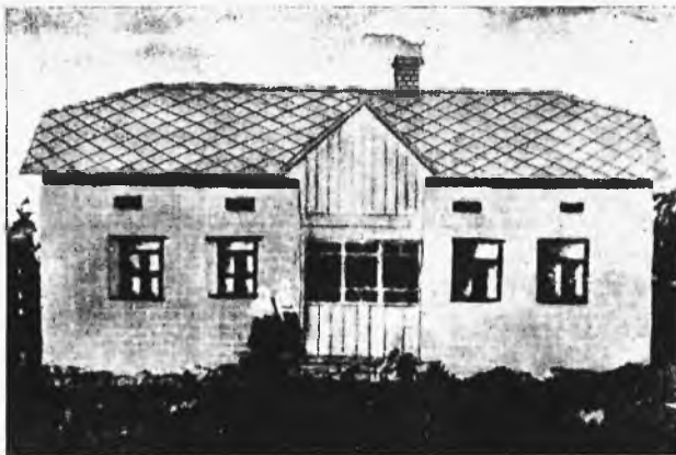
Ryc. 9. «Dom wieśniaczy we wschodniej Małopolsce»: ilustracja z anonsu jednej z fabryk eternitu. Oto typowy przykład propagandy materiałów sztucznych na wsi, rozpowszechniającej w sposób aż nazbyt łatwy «nowoczesne zdobycze techniki i postępu».
