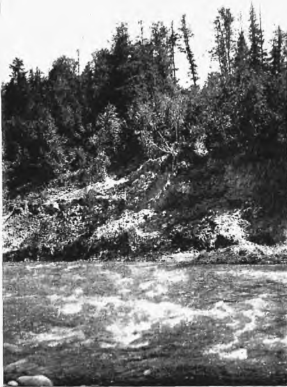
Ryc. 143. Rezerwat Kniaźdwór pod Kolomyją. Osuwisko nad Prutem w oddz. 31, spowodowane rozmywaniem brzegów.
