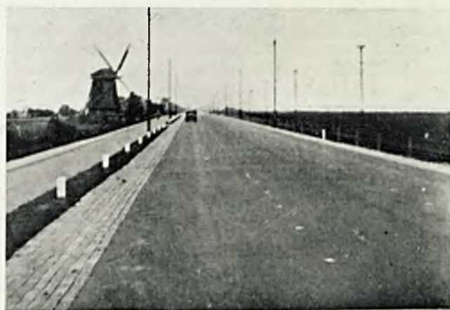
Fot. 4 i 5. Nawierzchnia bitumiczna.
