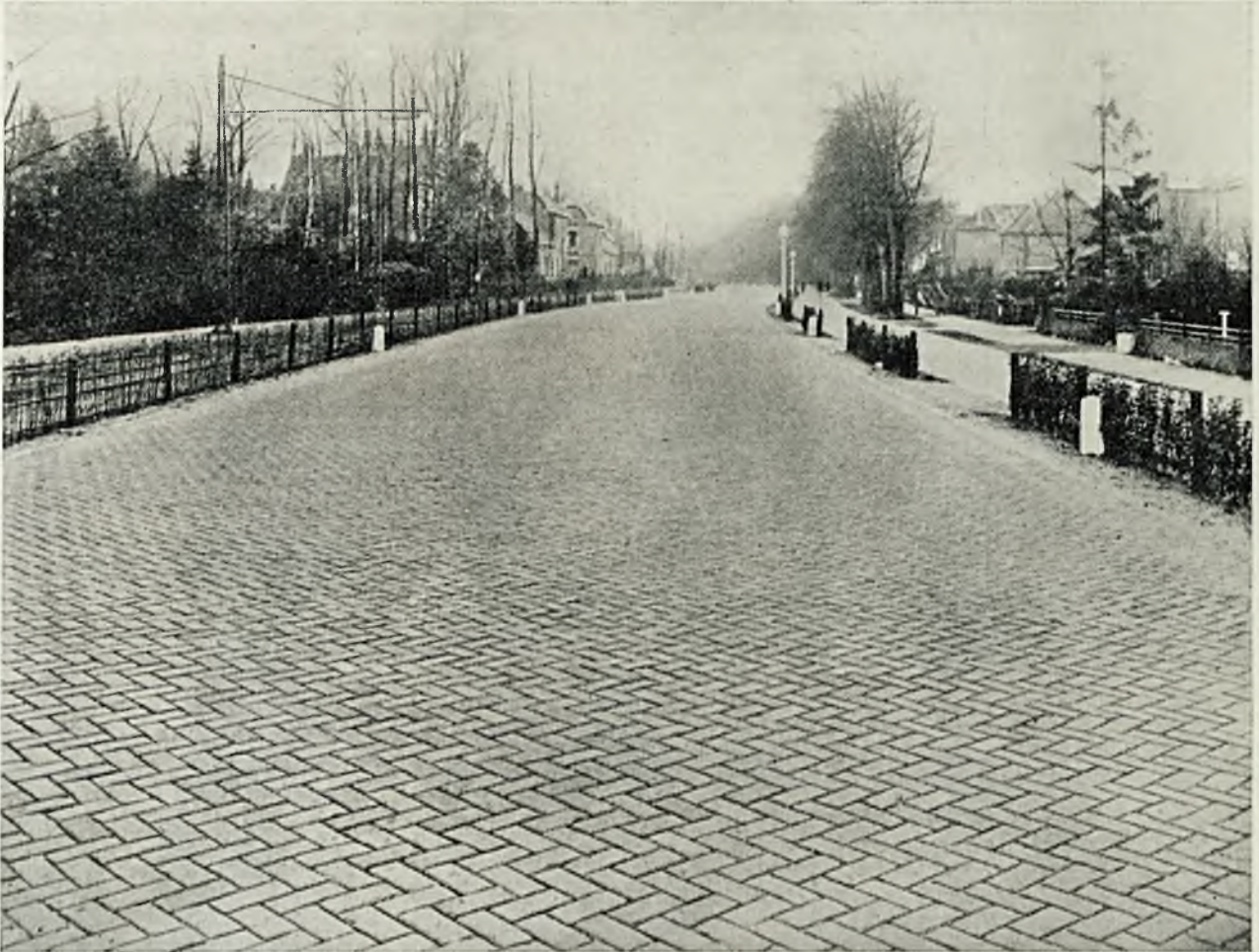
Fot. 6. Charakterystyczny przekrój poprzeczny, nawierzchnia klinkierowa.
