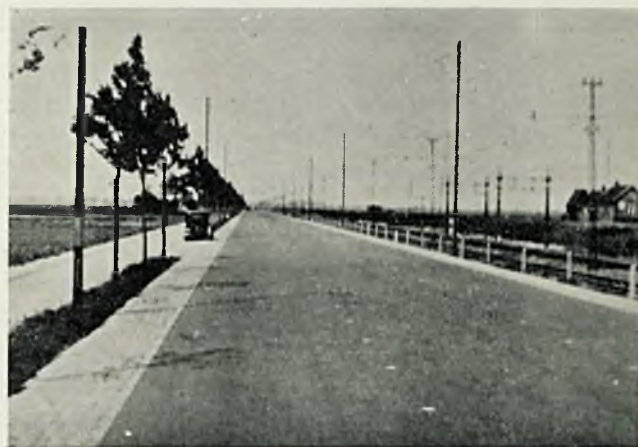
Fot. 4 i 5. Nawierzchnia bitumiczna.
