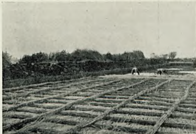
Fot. 14. Budowa drogi na bagnie.
