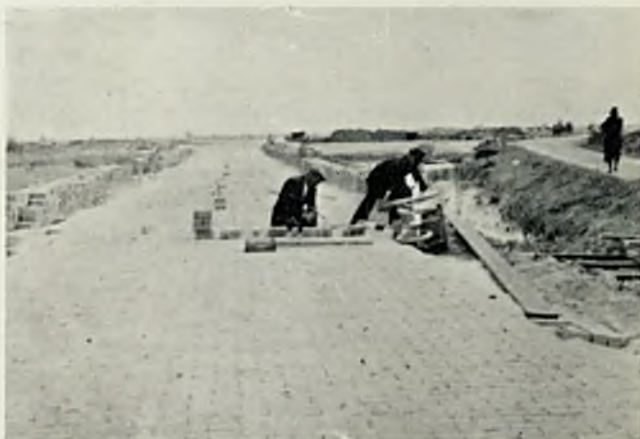
Fot. 8. Układanie nawierzchni klinkierowej na piasku.
