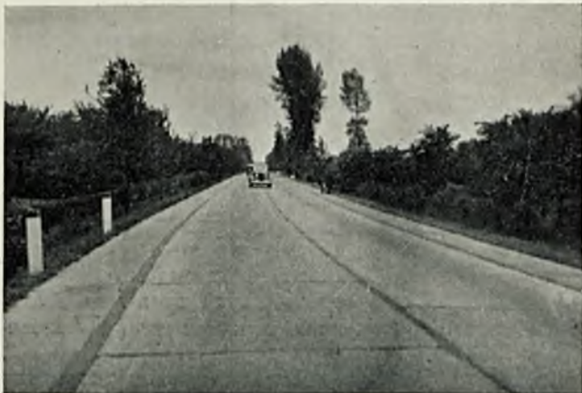
Fot. 2. Stara nawierzchnia betonowa.
