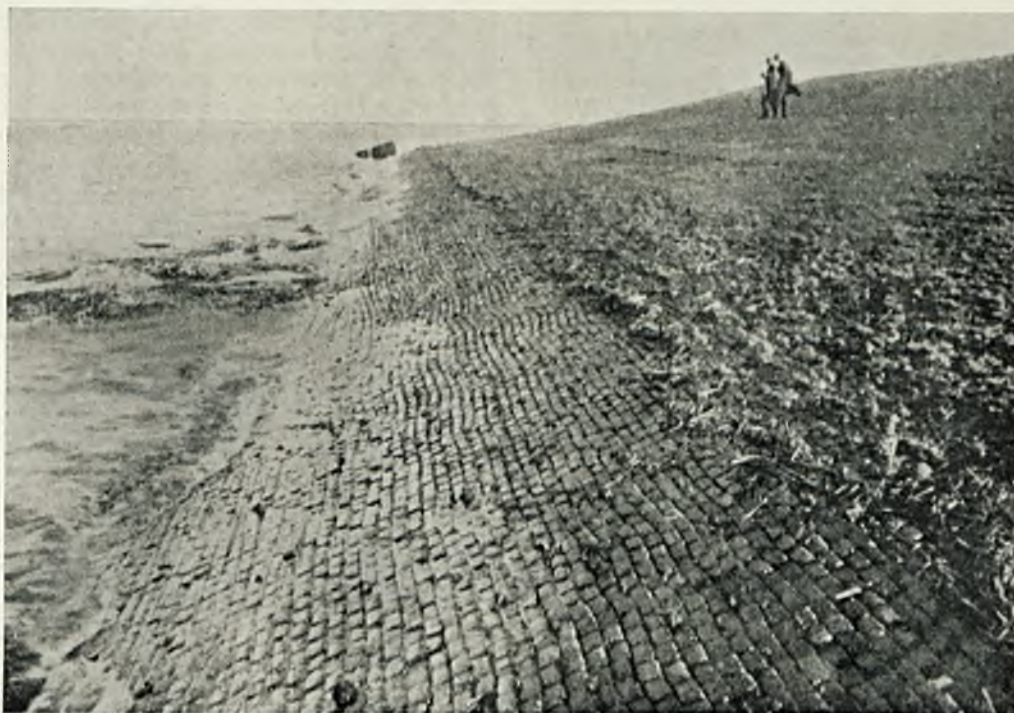
Fot. 11. Brukowanie skarp klinkierem.
