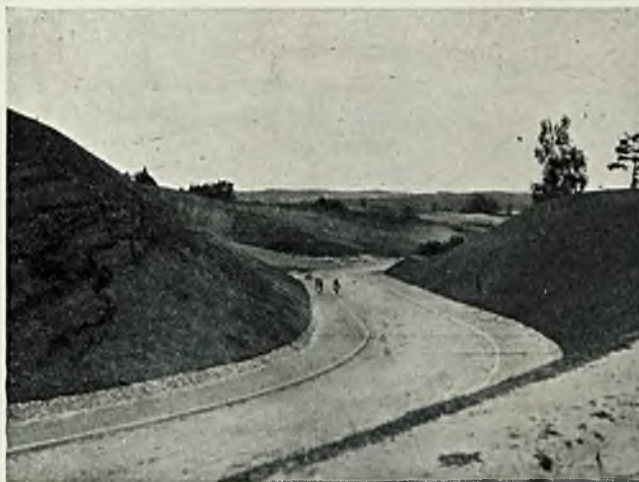
Ta sama droga po wykonaniu robót w r. 1936. Roboty prowadzi z ramienia Urzędu Woj. Wileńskiego inż. Laskowski.
