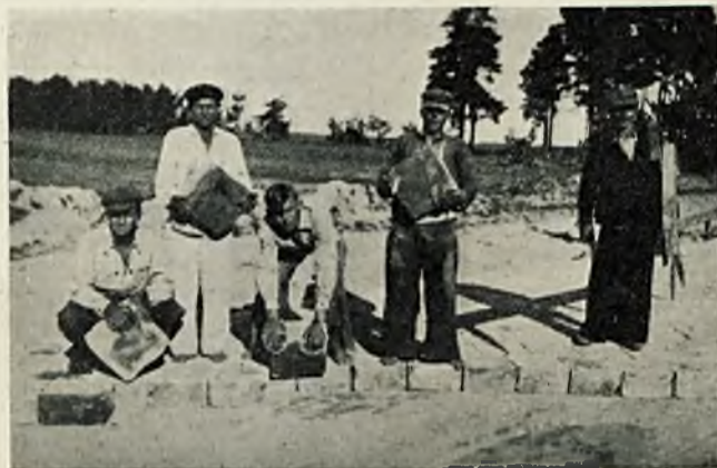
Układanie płyt kamiennie-betonowych.
