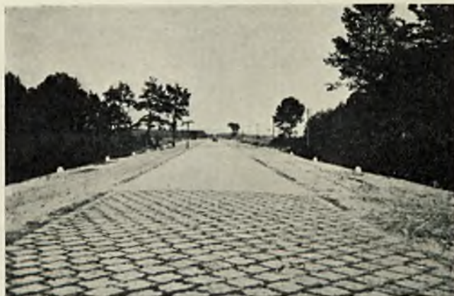
Jeźdźnia z płyt kamiennie-betonowych.
