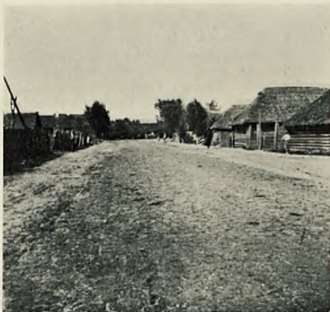
Droga po wykończeniu.
