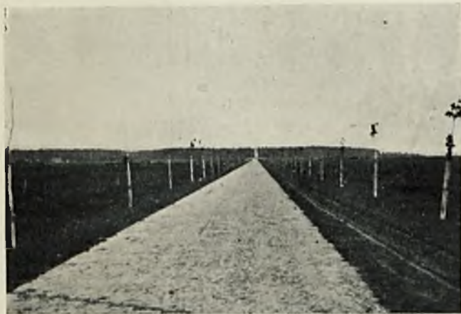
Fragment nowowybudowanej drogi.
