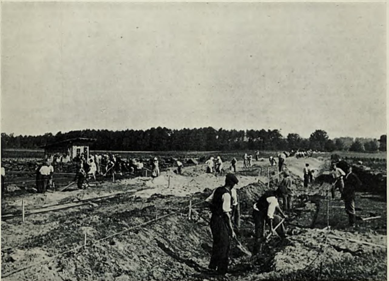
Budowa drogi Leżajsk - Sokółów.
