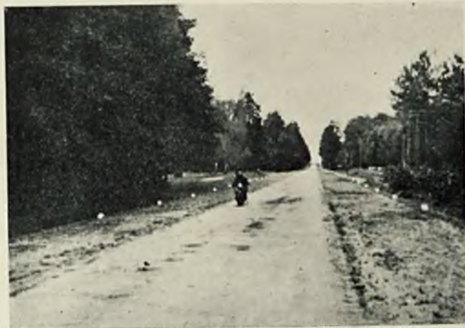
Fragment nowowybudowanej drogi.
