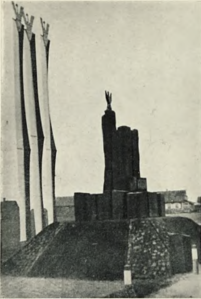
Pomnik budowy drogi w pow. Pińskim.
