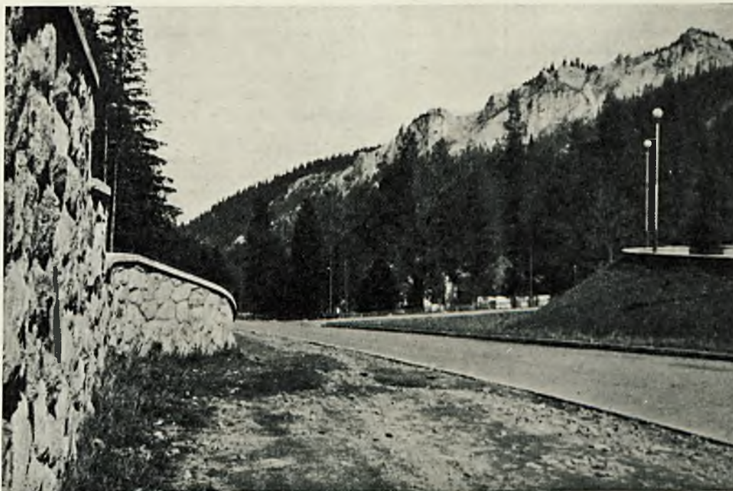
Droga do Kuźnic i plac przed dworcem kolejki linowej na Kasprowy Wierch.
