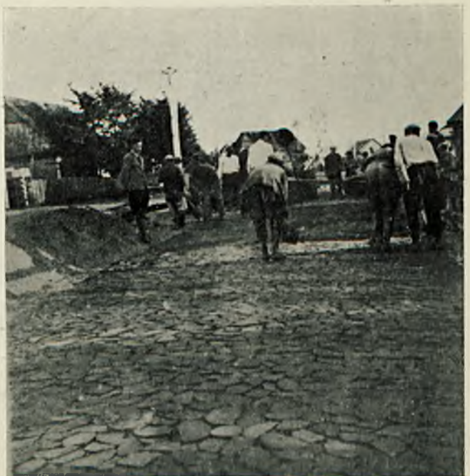
Ogólny widok robót.
