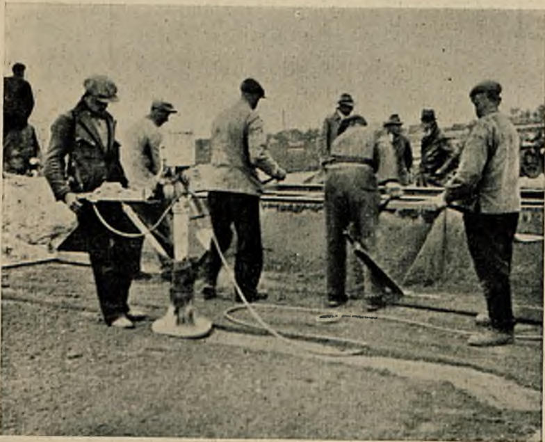
Rys. 4. Na pierwszym planie — ubijanie rozplanowanej mieszanki. Na drugim planie — opróżnianie zbiorniczków frezarki przez wywrócenie.
