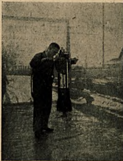
Rys. 44. Ubijak „Delmag” do bruku, wagi 100 kg.
