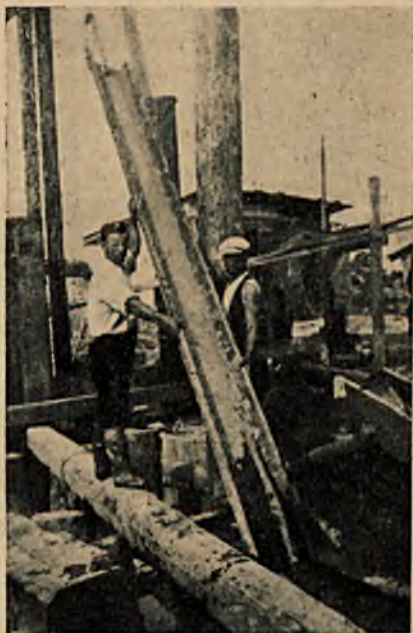
Rys. 15. Dźwignięcie elementu „Larssena”
