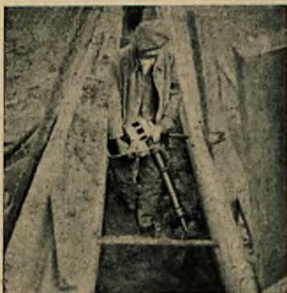
Rys. 67. Ubijanie betonu w ciasnym wykopie.
