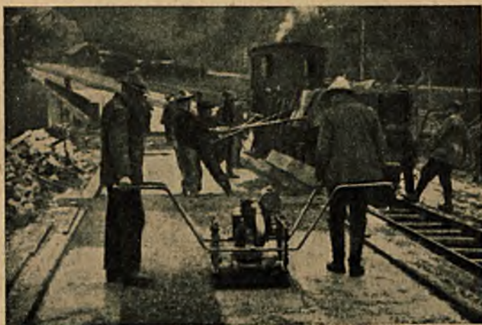
Rys. 66. Płyty wibrujące „Cisaris” o wymiarach 360 \times 600 — 1000 \times 600 mm, 600 \times 600 mm.
