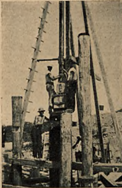
Rys. 10. Wbijanie podwójnego elementu
