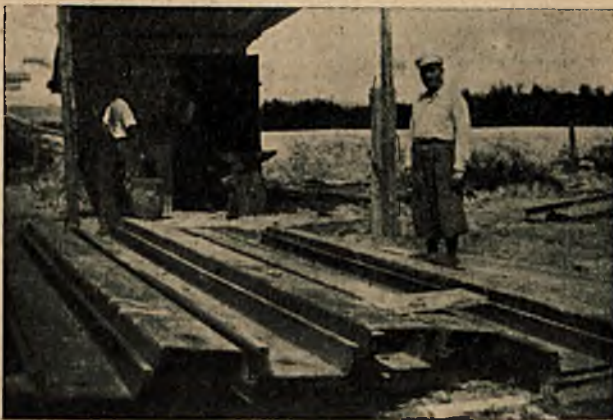
Rys. 7a. Podwójne elementy „Larsena”
