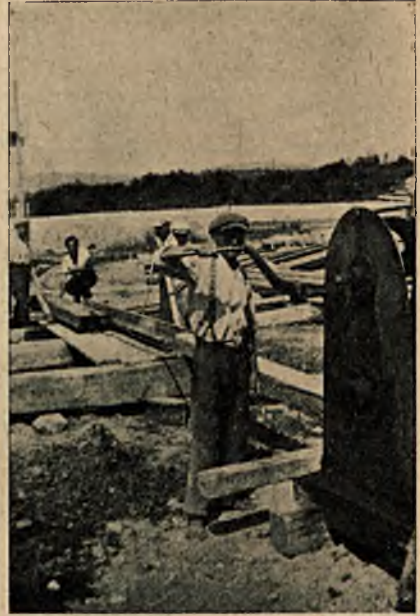
Rys. 7. Nasuwanie elementów „Larsena”
