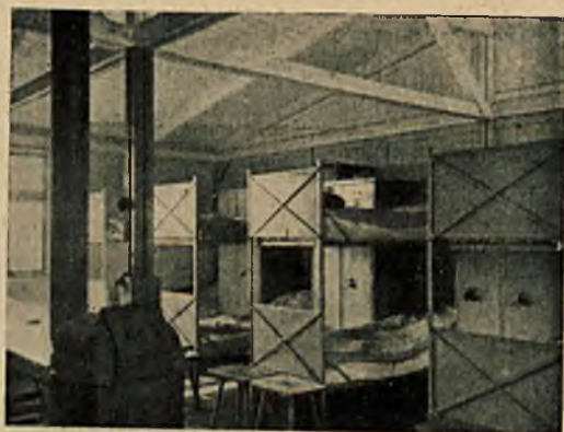
Rys. 75. Barak sypialny z ogrzewaniem.
