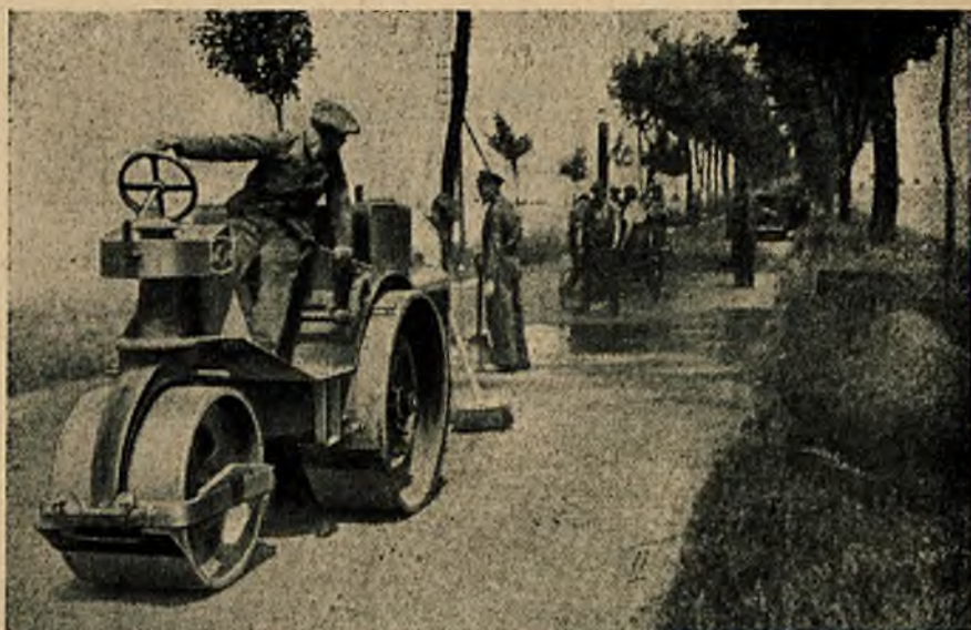
Rys. 48. 3,5/4,2 tonowy walec przy wałowaniu smołowanego grysłu.
