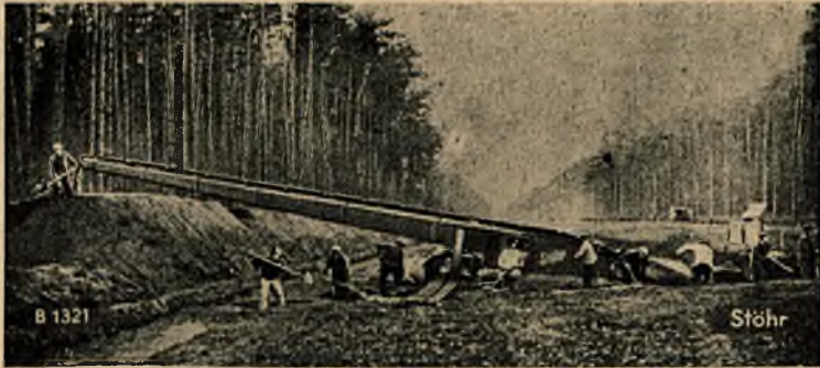
Rys. 43. Taśmy transportowe, przewoźne z nastawialną wysokością podnoszenia. Taśma nośna na rolkach.
