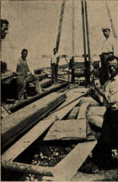
Rys. 7. Nasuwanie elementów „Larsena”
