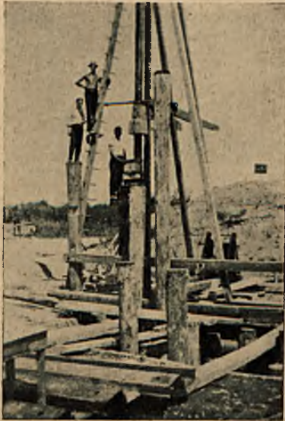
Rys. 13. Wbijanie ścianki „Larssena”
