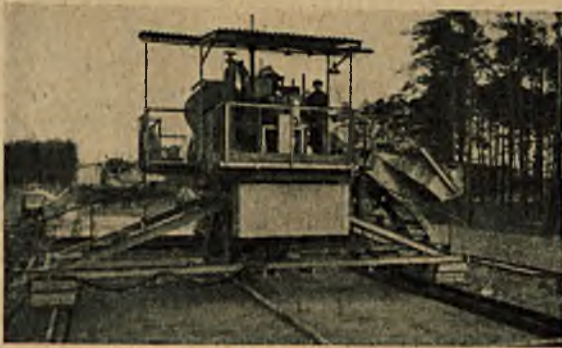
Rys. 62. Mieszarka do betonu o pojemności 1500 litrów z koszem i urządzeniem do przejścia w łukach.
