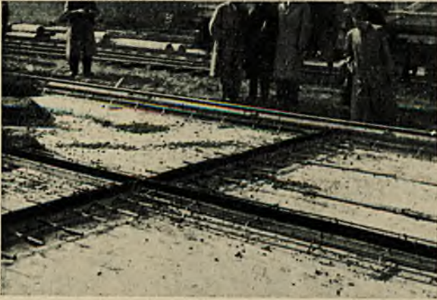
Rys. 32. Autostrada Norymberga — Lipsk. Zbrojenie i dyblowanie płyt.
