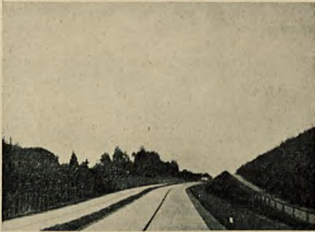
Rys. 9. Autostrada Monachium — Granica państwa. Droga polna poza autostradą na skarpie.
