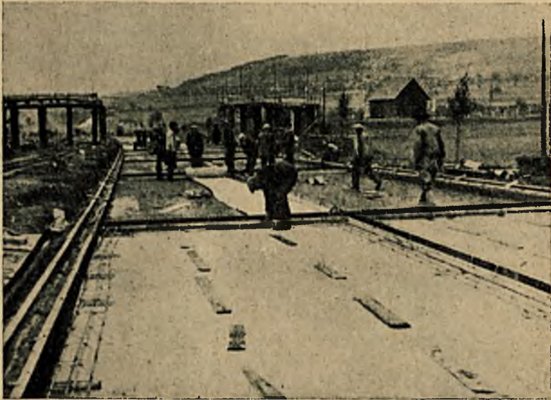
Rys. 26. Autostrada Norymberga — Lipsk. Układanie warstwy papieru.
