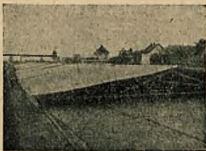
Rys. 38. Autostrada Norymberga-Lipsk. Dachy ochronne. Pokrycie matami i piaskiem.
