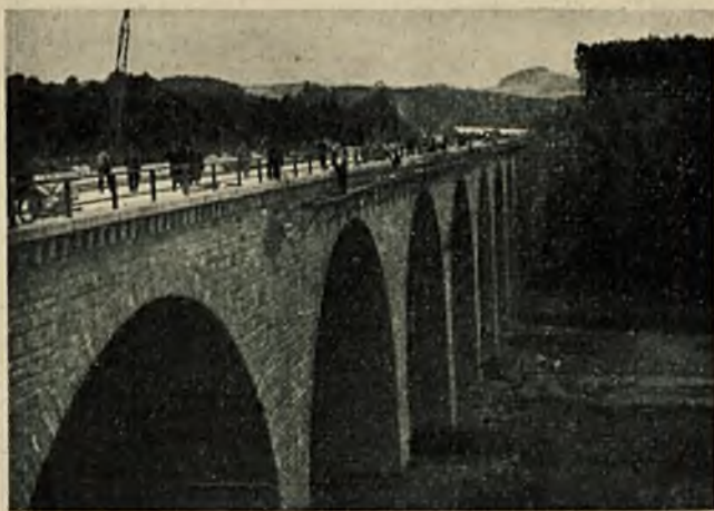
Rys. 18. Autostrada Norymberga — Lipsk. Wiadukt łukowy.
