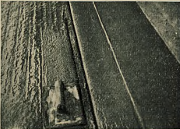
Rys. 33. Autostrada Norymberga — Lipsk. Obrabianie fug specjalną kielnią.
