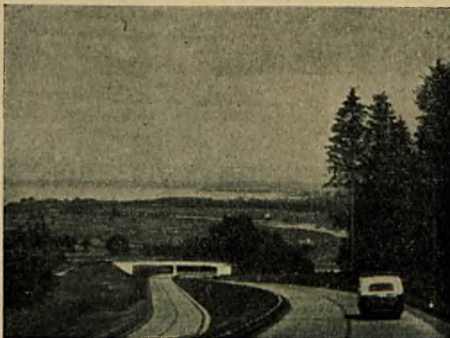
Rys. 8. Autostrada Monachium—Granica Państwa. Jezdnie na łukach w dwu poziomach.
