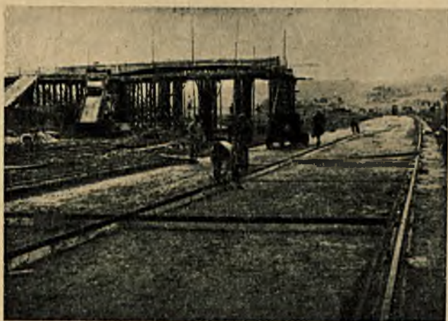
Rys. 29. Autostrada Norymberga—Lipsk. Układanie wkładek Wielanda.
