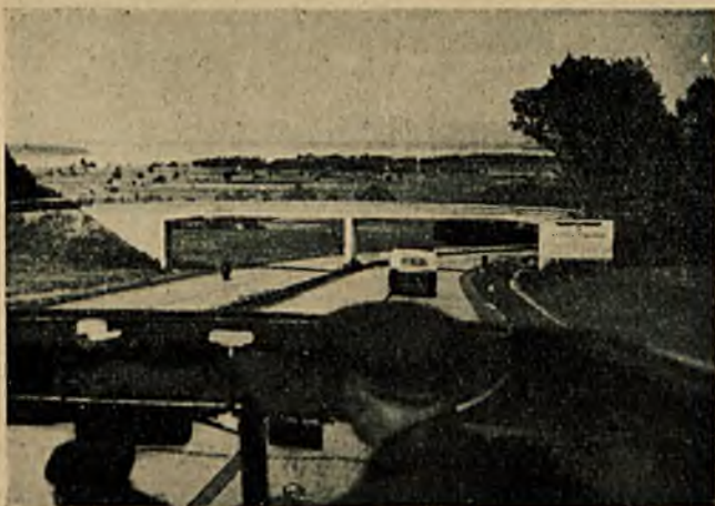
Ryr. 16. Autostrada Norymberga — Lipsk. Wiadukt ramowy — dwuprzęsłowy.
