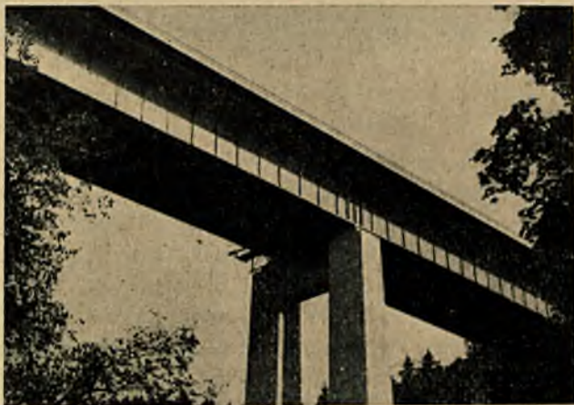
Rys. 20. Autostrada Monachium — Granica Państwa. Mongfalltalbrücke.
