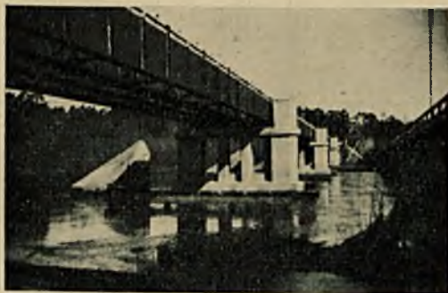
Rys. 9. Dźwigary stalowe ustawione na podporach.
