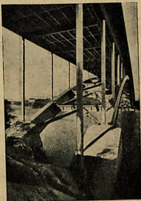
Rys. 43. Widok słupów i wie- townic.
