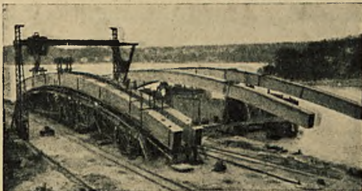
Rys. 45a. Widok mostu w czasie montażu.
