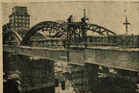
Rys. 50. Nowy most św. Eryka w trakcie budowy.
