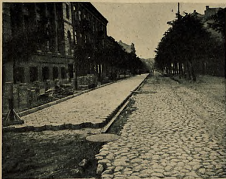
Ulica Kościuszki we Włocławku. Zamiana bruku na jezdnię z płyt betonowych w 1935 r.
