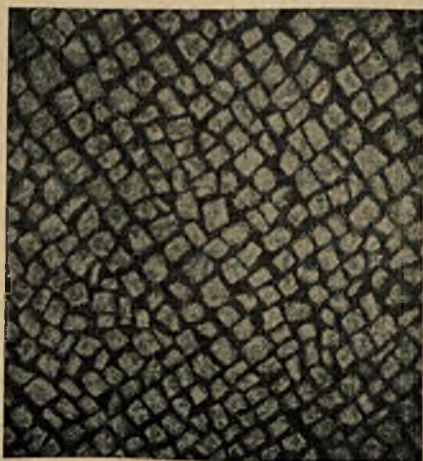
Ryc. 4. Kostka mozaikowa z drobnej kostki 4/6 cm, osadzonej w cemencie.
