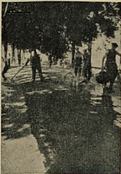
Ryc. 9a. Bitumowanie powierzchniowe asfaltem na gorąco.
