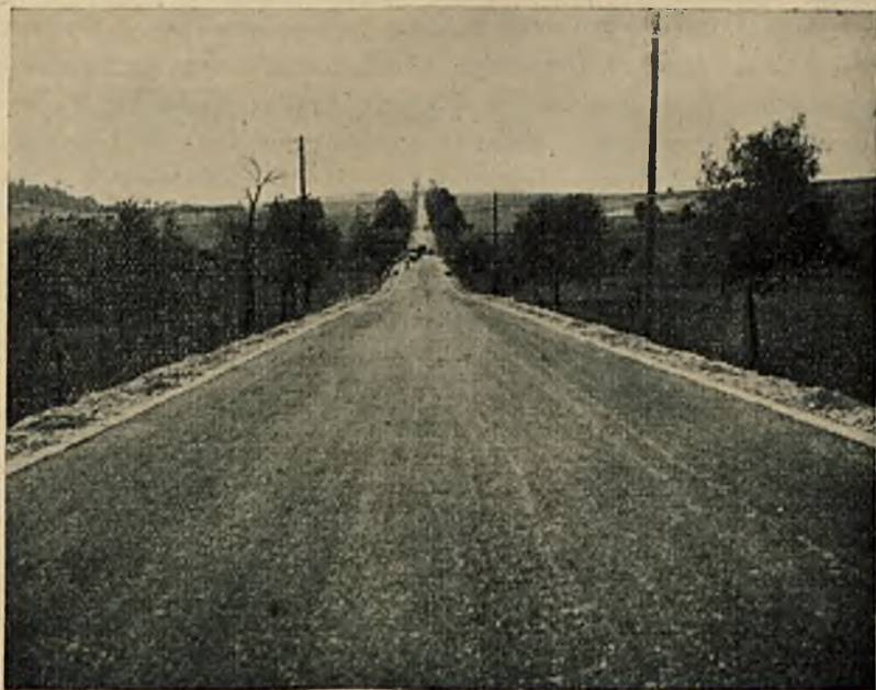
Ryc. 16. Droga smołobetonowa 6 cm na drodze państwowej Bernu — Cieszyn (firma Rüttgers).
