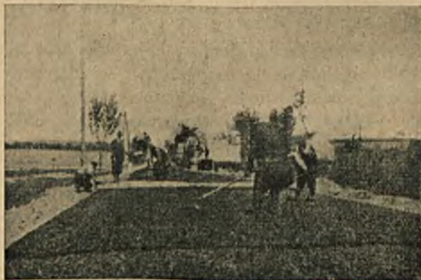
Ryc. 10. Budowa makadamu metodą „wyspną” przy pomocy kruszywa bitumowanego upłynnionym asfaltem.
