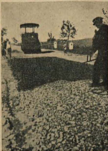
Ryc. 9. Bitumowanie powierzchniowe emulsją asfaltową.
