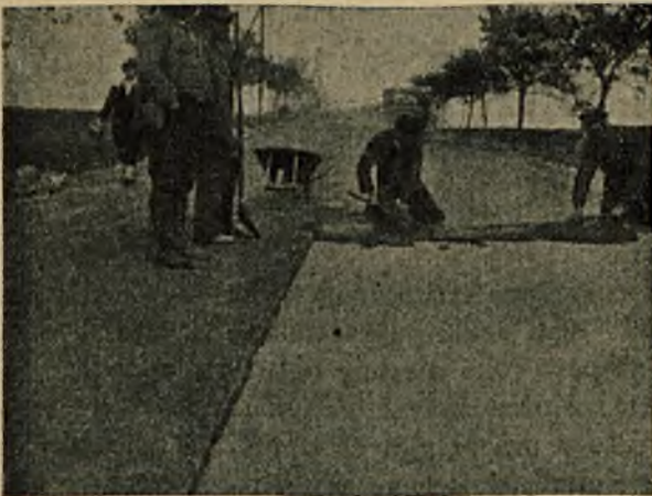
Ryc. 12. Droga państwowa z asfaltu lanego.
