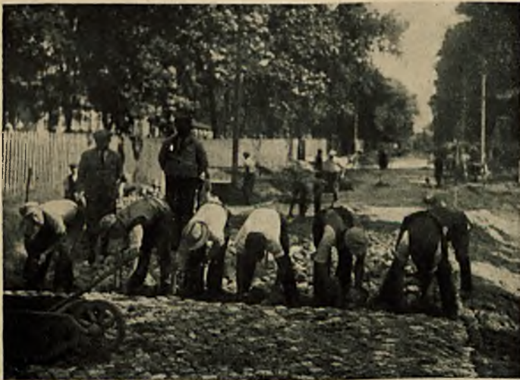
Rys. 4. Układanie kostki w „mozajkę” przez pomorskich brukarzy na drodze państwowej Nr. 9.
