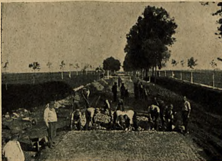
Rys. 5. Układanie kostki w łęki przez pomorskich brukarzy na drodze państwowej Nr. 9 koło Garwolina.
