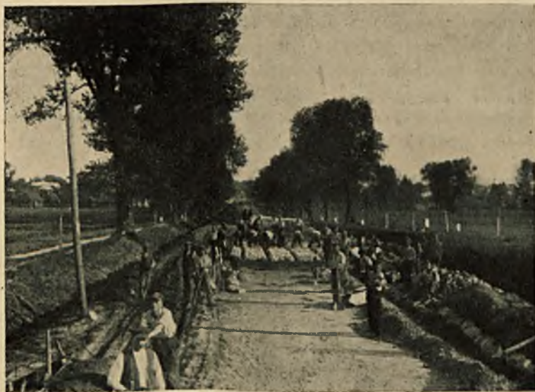
Rys. 6. Układanie kostki „w łąki”. Pobocza suche — objazd niedostatecznie umocniony.
