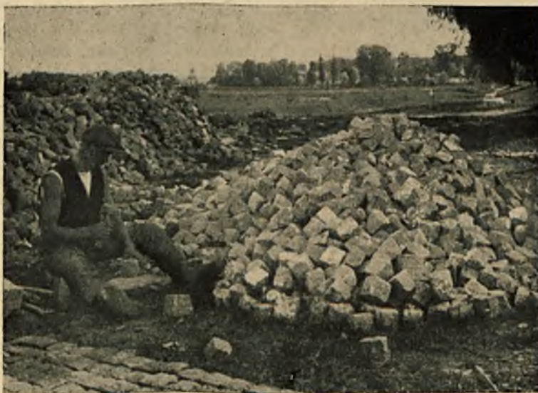
Rys. 1. Wyrób kostki nieregularnej przez pomorskich kamieniarzy „Pucowanie” (formowanie) małemi młotkami.
