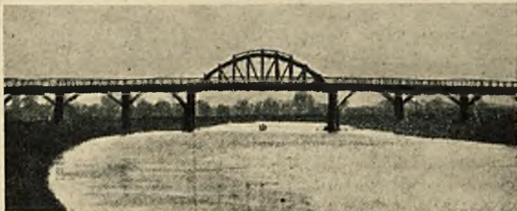
Rys. 1. Most drewniany o prześle środkowym syst. Francosa.
