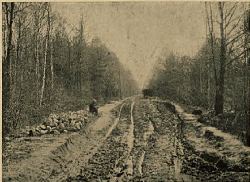
Rys. 1. Droga gm. st. Garwolin — Budy Uśniackie. Przed budową.
