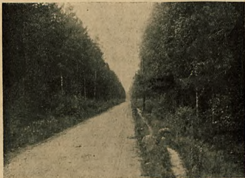
Rys. 2. Droga gm. st. Garwolin — Budy Uśniackie. Ten sam odcinek po budowie.
