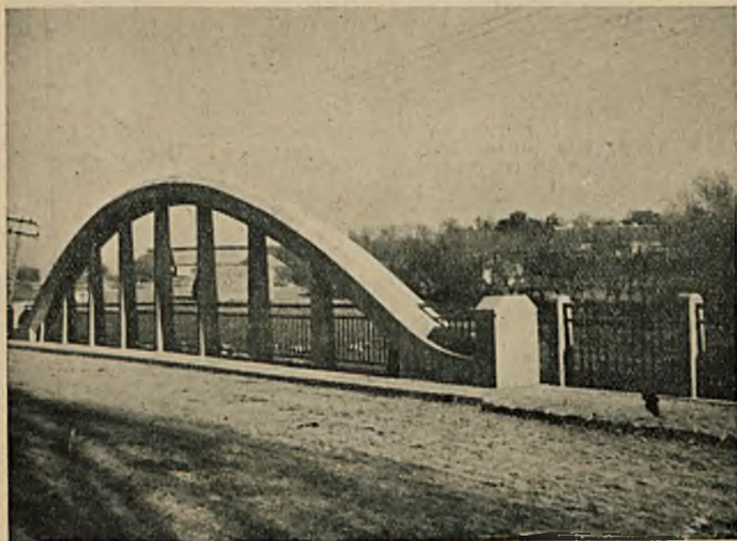
Ryc. 3. Widok łuku od strony jezdni.
