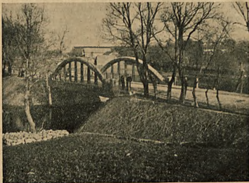
Ryc. 1. Ogólny widok mostu.
