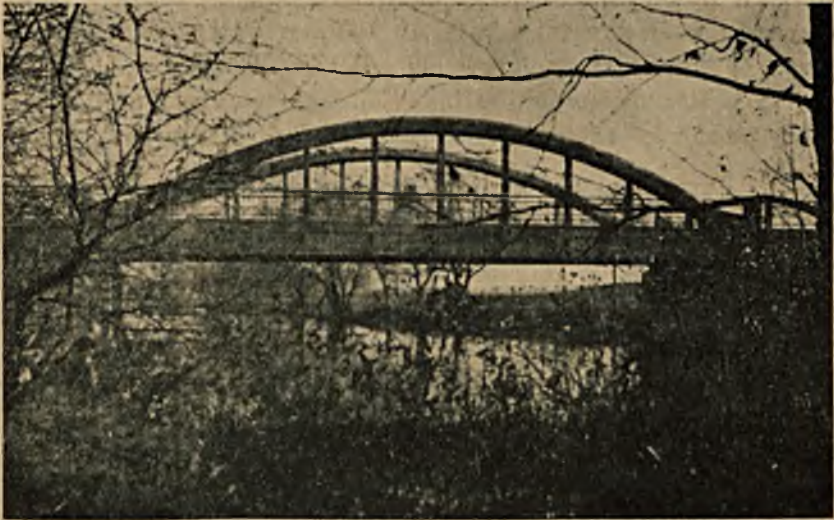
Ryc. 2. Widok mostu z boku.
