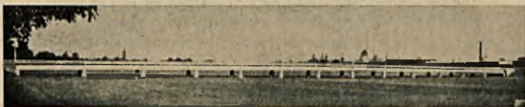
Rys. 3. Most w Dreźnie. Konstrukcja całkowicie spawana.
