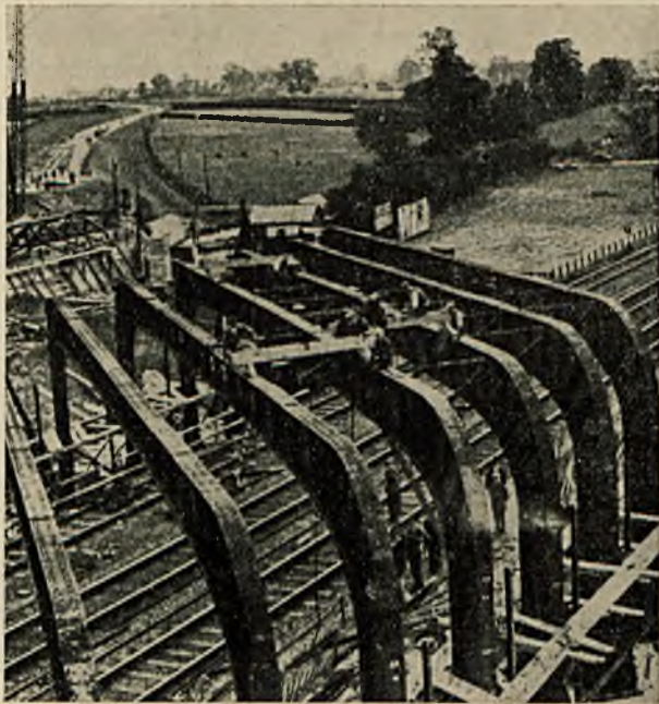
Rys. 11. Montaż ramownic mostu Lower-Wolvercote.
