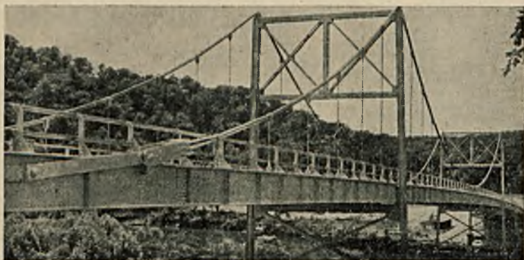
Rys. 12. Ciekawe zakotwienie wieszarów mostu przez Little - Niaugua (St. Zj.), światło środkowego otworu 68,5 m.
