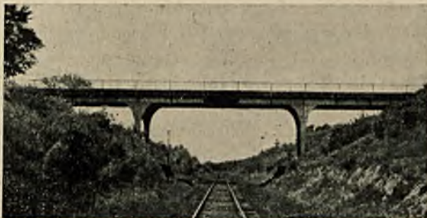
Rys. 6. Most ramowy pod Albia (Iowa St. Zj.) światło 19,80 m.
