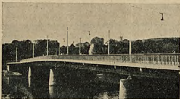
Rys. 4. Most pod Werdun. Belka ciągła ze stali St. 52.
