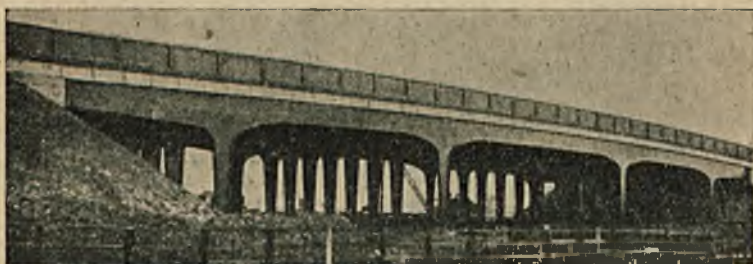
Rys. 10. Całkowicie spawany most ramowy w Newport-on-Tees.
