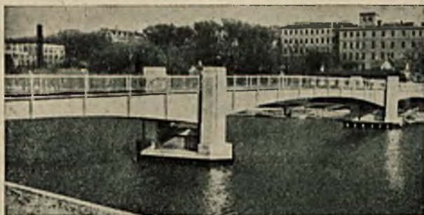
Rys. 2. Most w Jowa City St. Zj. Belka ciągła o rozpięt. 36+55+36 m. św.
