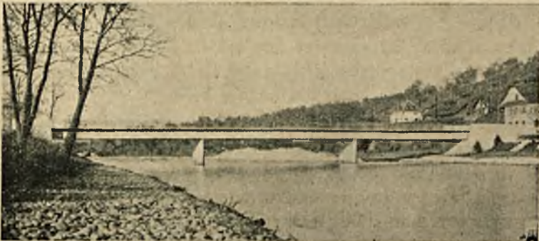
Rys. 5. Widok mostu Gisikon po ukończeniu budowy.
