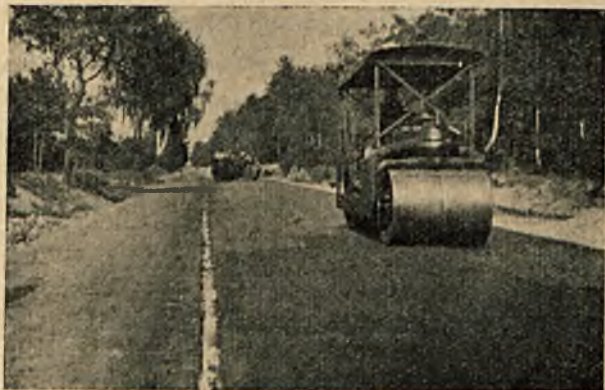
Rys. 5. Wałowanie.
