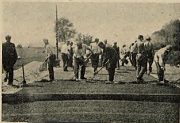
Rys. 4. Układanie nawierzchni.
