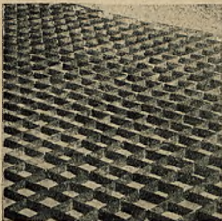
Rys. 4. Szkielet żelazny jako wzmocnienie betonowej nawierzchni.
