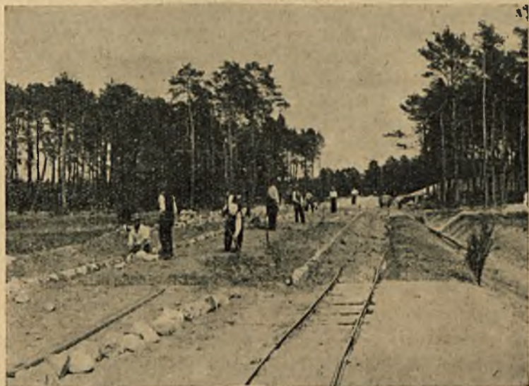
Rys. 6. Budowa drogi Warszawa—Izabelin—Puszcza Kampinowska
