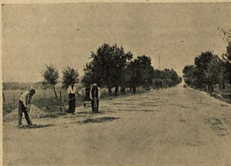
Rys. 1. Remont cząstkowy.
