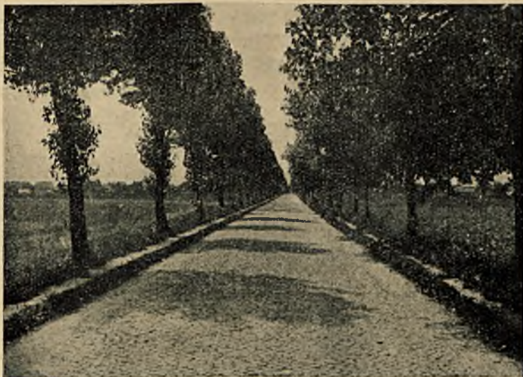
Rys. 4. Kostka nieregularna na drodze Warszawa — Pruszków.
