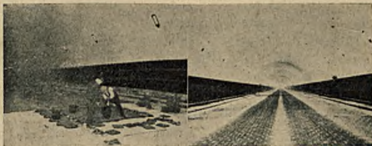
Rys. 2. Układanie nawierzchni z płyt żelaznych w tunelu w Mersey.
