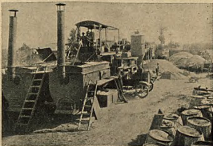
Rys. 7. Maszyny do nawierzchni bitumicznych z kotłami do topienia asfaltu.
