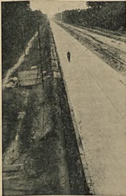
Rys. 19. Jezdnia betonowa wykończona na połowie szerokości. (Fot. p. W. Gr.)
