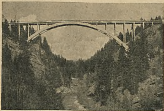
Rys. 12. Most pod Echelsbach: łuk żelbetowy rozpiętości 130 m.
