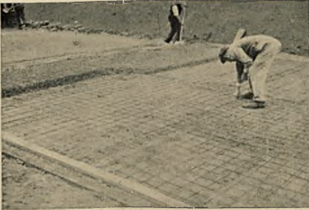
Rys. 18. Układanie siatki stalowej przy budowie jezdni betonowej. (Fot. p. W. Gr.)
