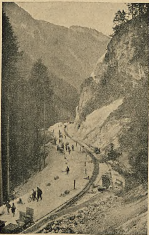
Rys. 15. Odcinek niemieckiej drogi alpejskiej w przebudowie (Mauthhäuslstrasse).
