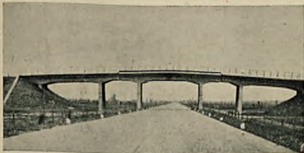
Rys. 17. Typowe skrzyżowanie autostrady z drogą boczną.
