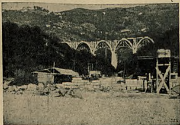
Rys. 14. Wiadukt żelazobetonowy na autostradzie Genua — Serravalle.
