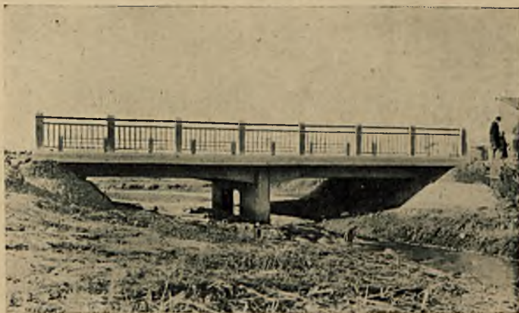
Rys. 5. Widok całkowicie ukończonego mostu w Tarczynie.
