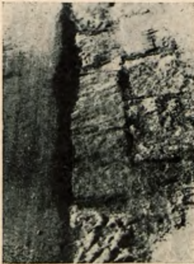
Rys. 22. Krawężnik obniżony.
