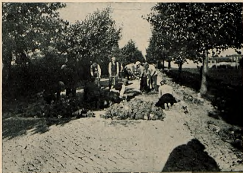
Rys. 11. Układanie nawierzchni z kostki nieregularnej.
