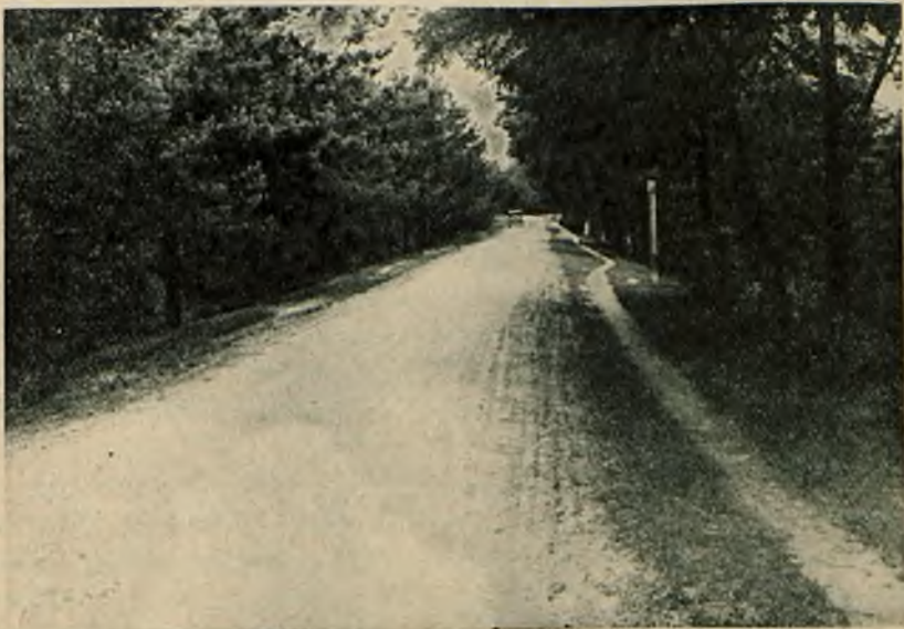
Rys. 1. Droga Struga—Jabłonna w pow. warszawskim. Intensywność ruchu 344 tonn na dobę. Nawierzchnia szabrowa po 3 latach znajduje się w stanie b. dobrym.
