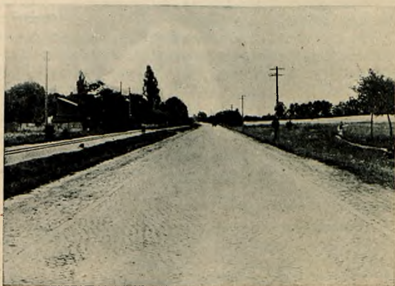
Rys. 6. Nawierzchnia z regularnej kostki bazaltowej, wykonana w 1930 r. na 10, 11 i 12 km. tr. Kowieńskiego na starej szosie.
