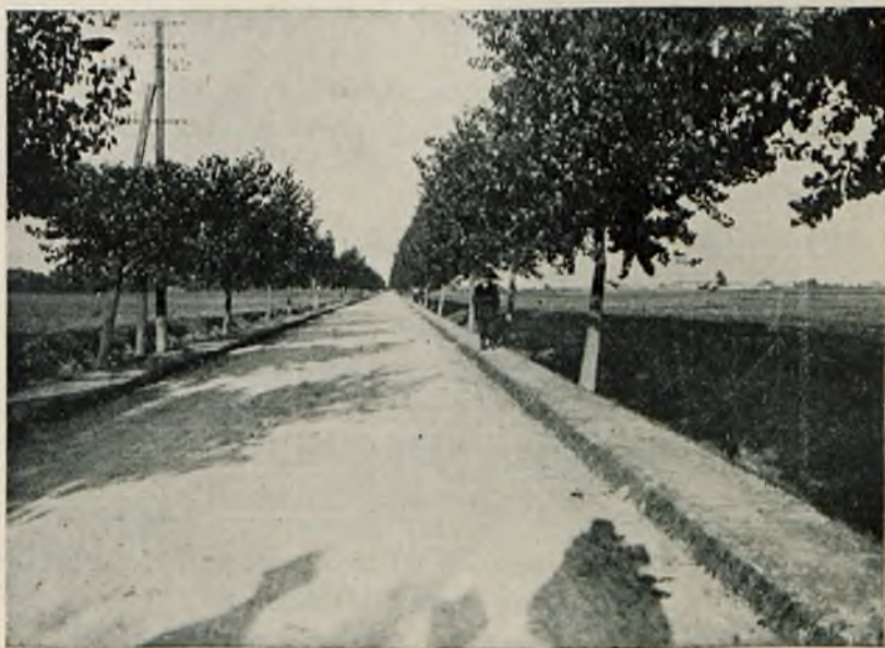
Rys. 19. Trakt Warszawa—Pruszków w pierwszym miesiącu po przebudowie.
