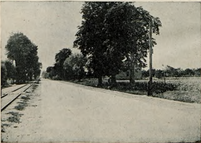
Rys. 3. Nawierzchnia z betonu asfaltowego systemu Warrenite-Bitulithic wykonana w 1930 i 1931 r. przez Sejmik pow. Warszawskiego, na odcinku od km. 8.600 do km. 17.678 tr. Puławskiego (do Piaseczna).
