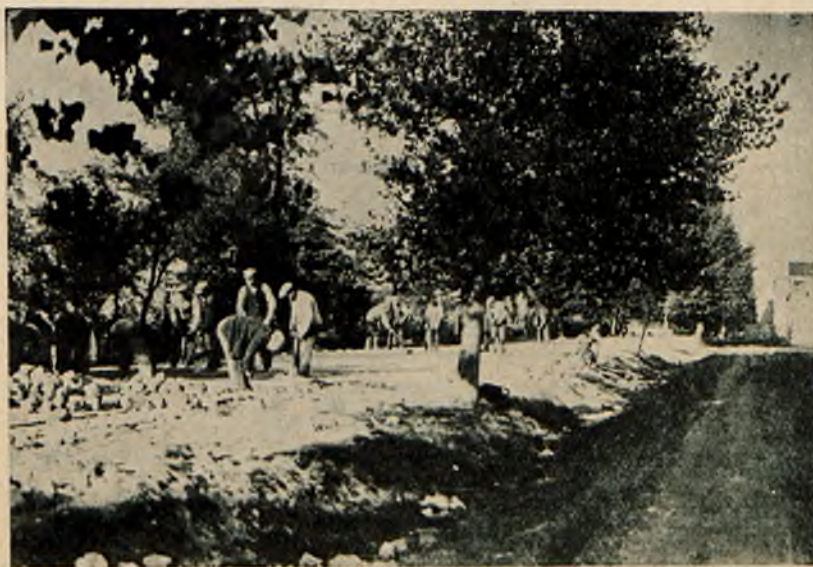
Rys. 12. Układanie nawierzchni z kostki nieregularnej.
