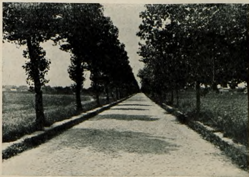
Rys. 20. Trakt Warszawa — Pruszków w rok po przebudowie.
