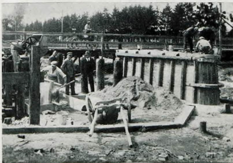
Rys. 5. Szalowanie filaru (filar zabetonowany).
