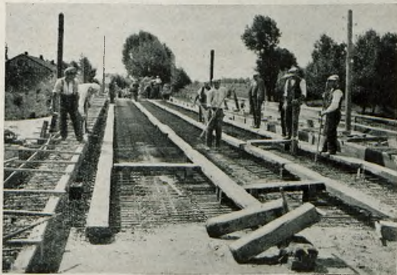
Rys. 9. Zbrojenie płyty i betonowanie.
