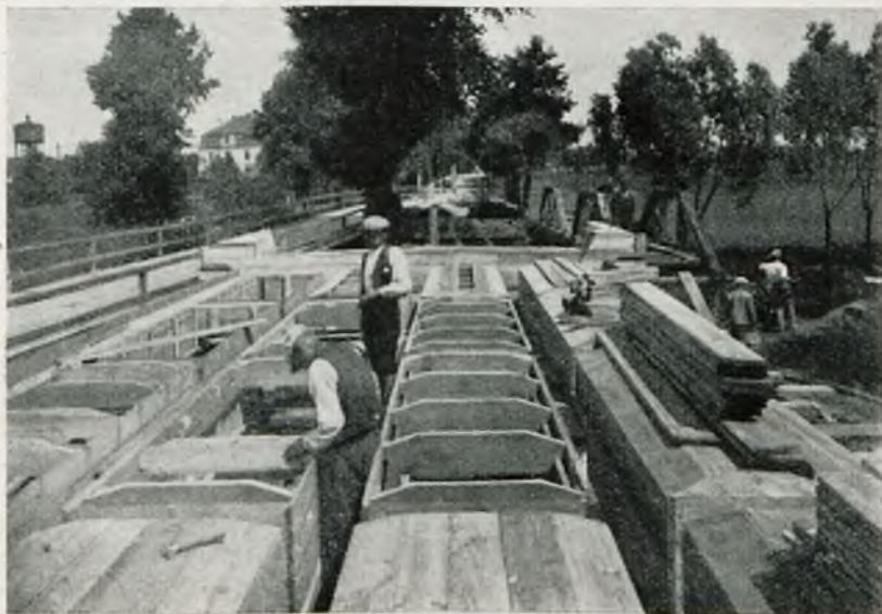
Rys. 7. Szalowania ustroju niosącego.
