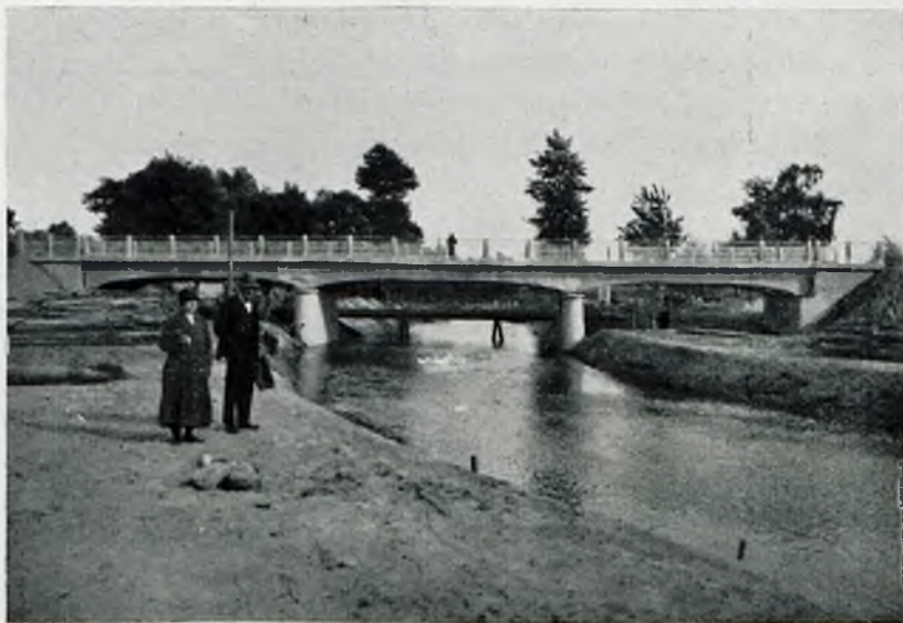
Rys. 10. Ogólny widok mostu.
