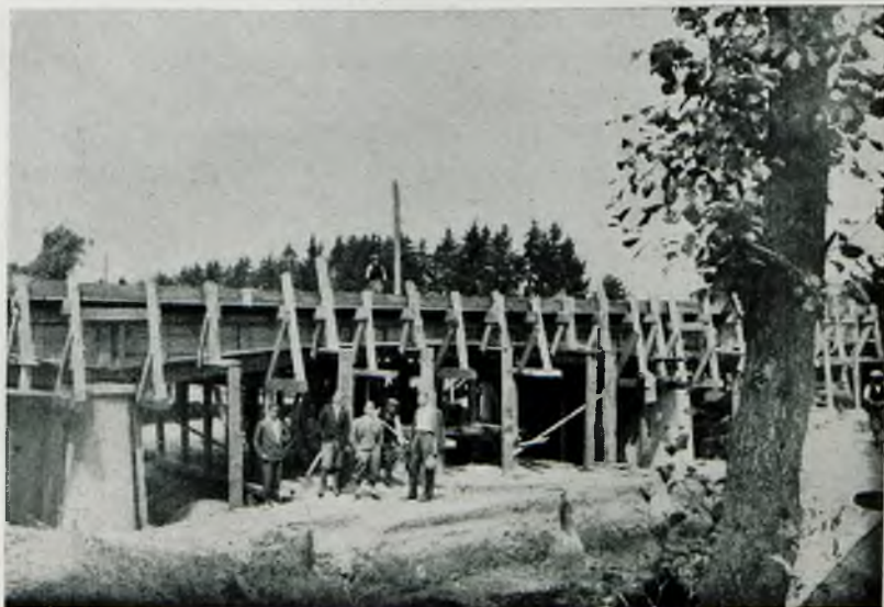
Rys. 6. Rusztowania ustroju niosącego.
