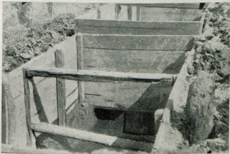
Rys. 4. Dół fundamentowy po opuszczeniu skrzyń.
