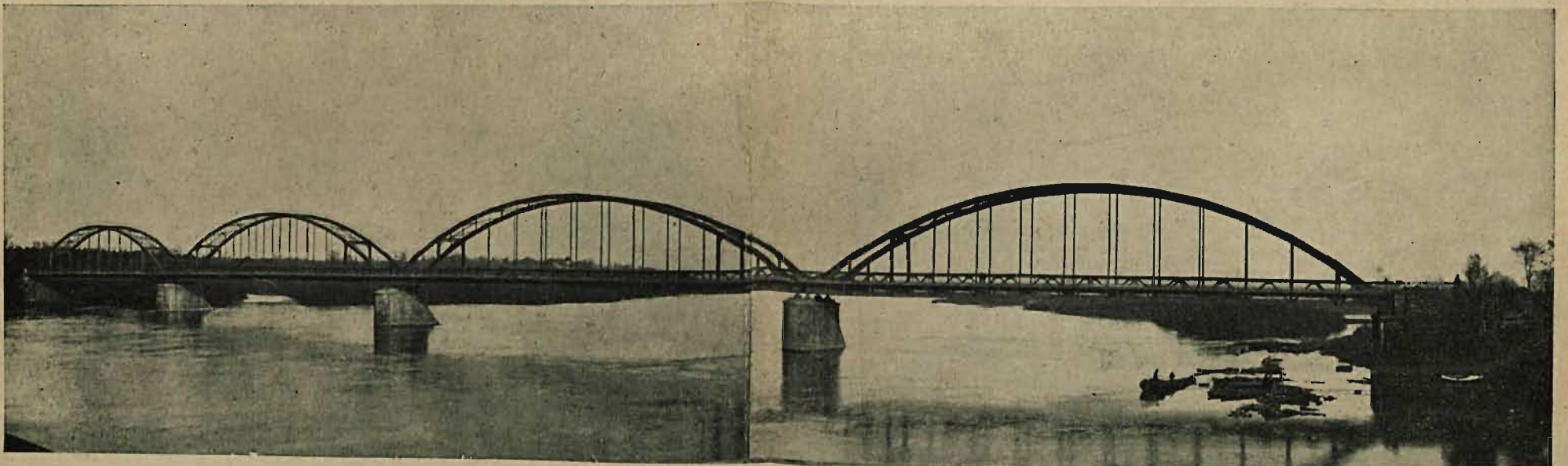
Rys. 14. Ogólny widok odbudowanego mostu na Bugu w Zegrzu.
