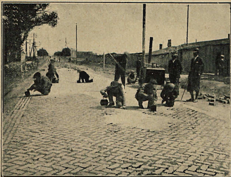
Rys. 5. Początek zalewania spoin asfaltem.
