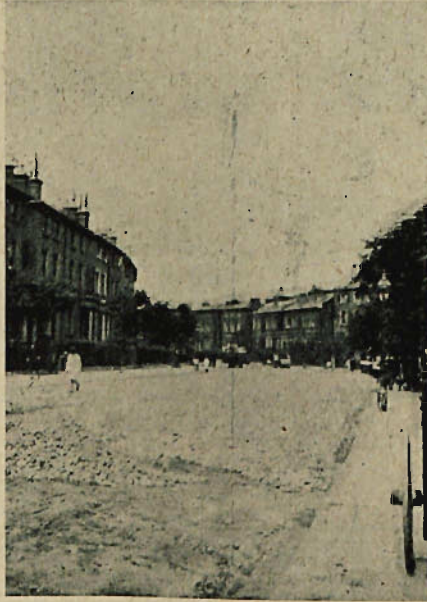
Rys. 39. Rozsypywanie świeżego tłucznia po uprzątnięciu zerwanej nawierzchni.
