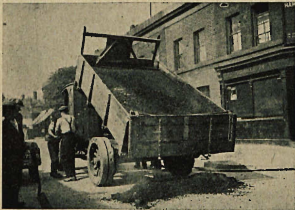
Rys. 54. Wysypywanie mieszanki asfaltu walcowanego na gotowe podłoże
