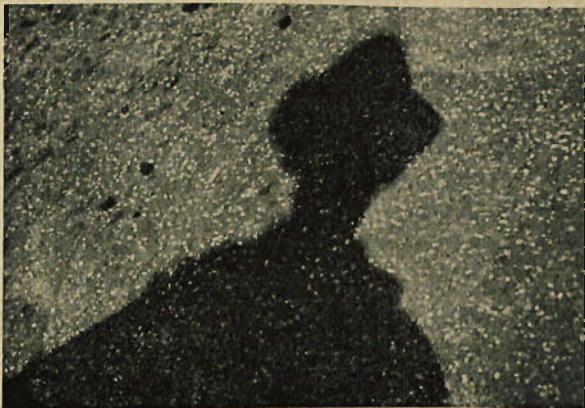
Rys. 61. Nawierzchnia asfaltowa po roku wykazuje mozaikowy ustrój. Plamy czarne pochodzą od oliwy samochodowej.
