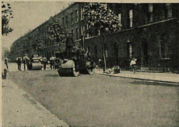
Rys. 57. Wałowanie asfaltobetonu dwoma walcami równoległe do osi i po przekątnej. (Anglia).
