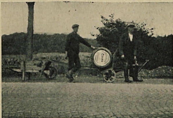
Rys. 36. Wykonywanie toru dla cyklistów na poboczu drogi przy pomocy emulsji.
