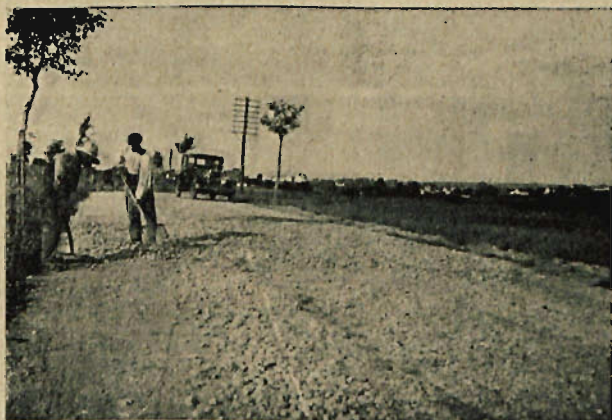
Rys. 45. Uzupełnianie z oskardowanej nawierzchni świeżym tłucznem.
