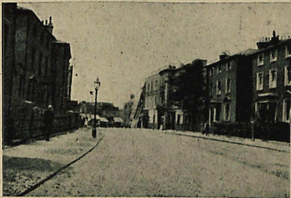
Rys. 40. Prawa strona ulicy została jednokrotnie polana smołą i zagrysiowana, lewa — przygotowana do nalewu. Na chodniku — przygotowany grys.
