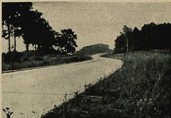
Rys. 66. Droga betonowa w Anglii, szerokie pobocza pozwalają na założenie chodników, ew. na poszerzenie drogi.
