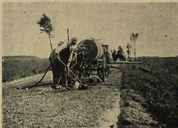
Rys. 46. Spłukiwanie nadmiaru piasku przed rozlaniem emulsji.
