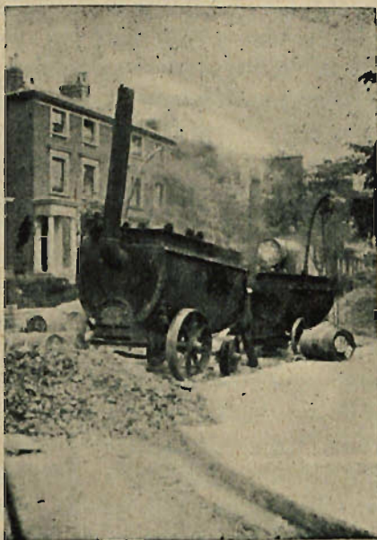
Rys. 42. Kotły do rozgrzewania bitumu (Anglja).
