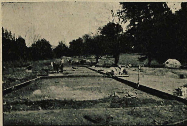
Rys. 69. Montowanie form i zakładanie papy izolującej szwy.
