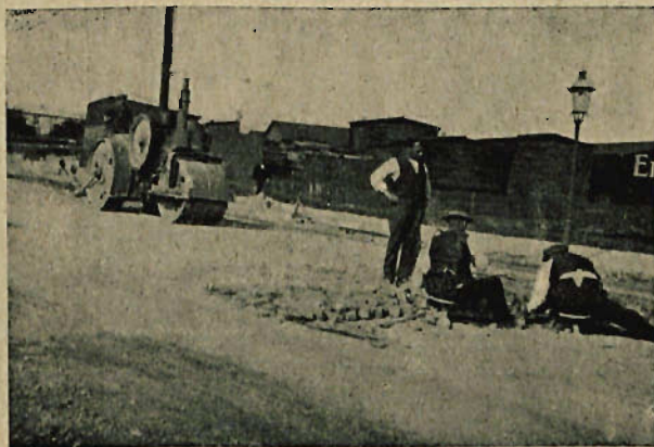
Rys. 65. Układanie i wałowanie drobnej kostki (Danja).
