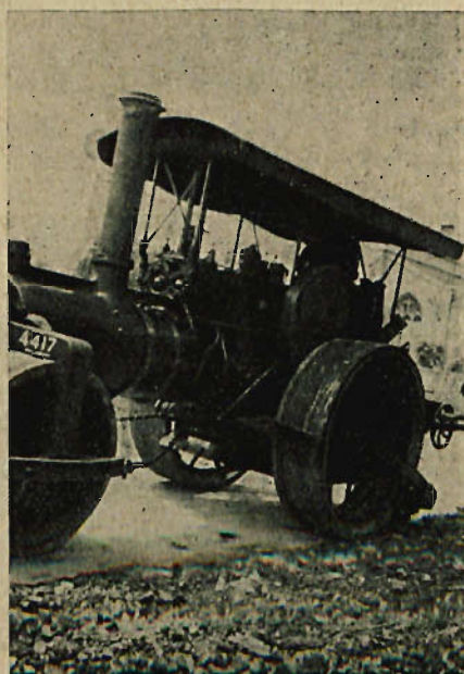
Rys. 38. Zrywanie starej nawierzchni utrwalonej powierzchniowo (Angja).
