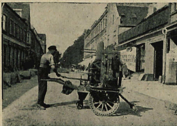
Rys. 62. Ubijanie starej kostki do profilu, przed pokryciem jej asfaltem lanym (Danja).
