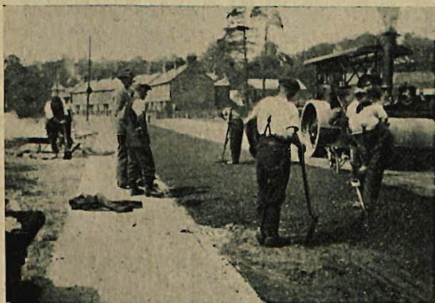
Rys. 55. Rozsypywanie mieszanki asfaltobetonu łopatomi, równanie do profilu grabiami.
