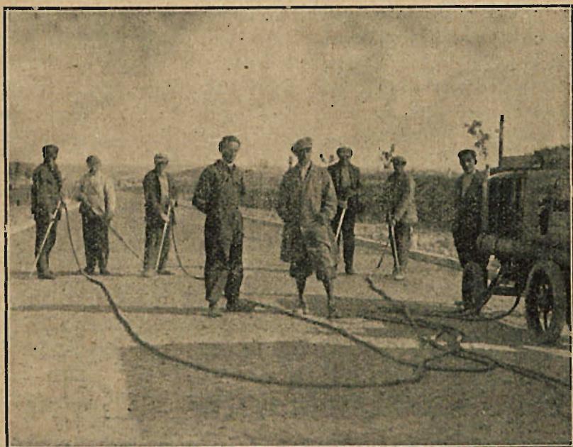
Rys. 3. Bruk z półbruczku po wydmuchaniu spoin przed zalaniem asfaltem.
