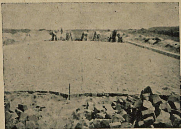
Rys. 1. Układanie bruków z półbruczku w łęki.
