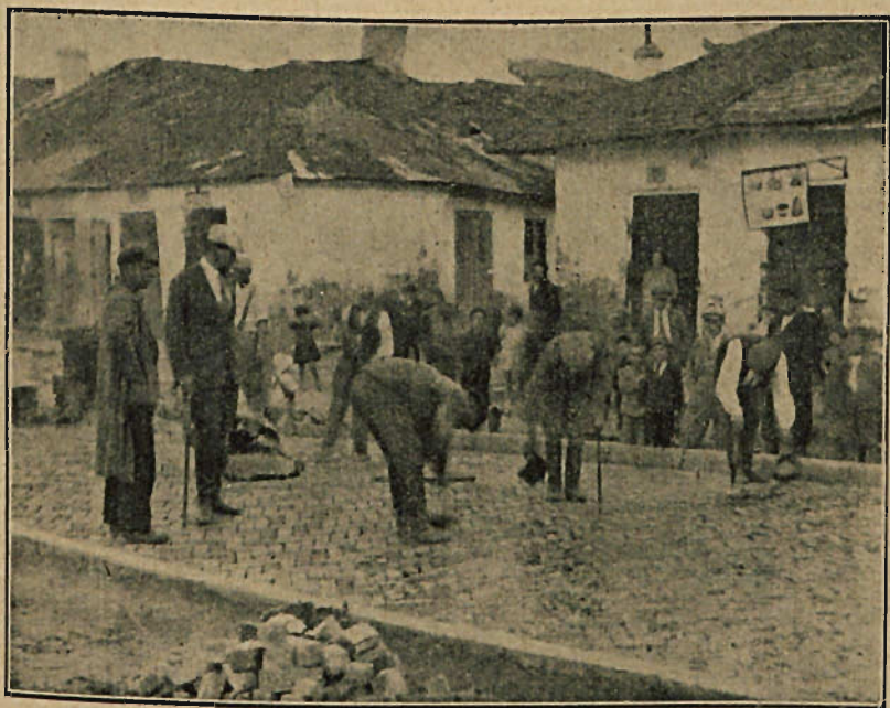
Rys. 1. Zalewanie asfaltem spoin w bruku klinkierowym na doświadczalnym odcinku w Izbicy we wrześniu 1930 r., dokonane przez Klinkiernię Państwową w Izbicy.
