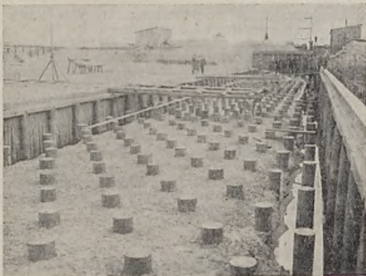
Pilotowanie fundamentów jazu na Bugu
