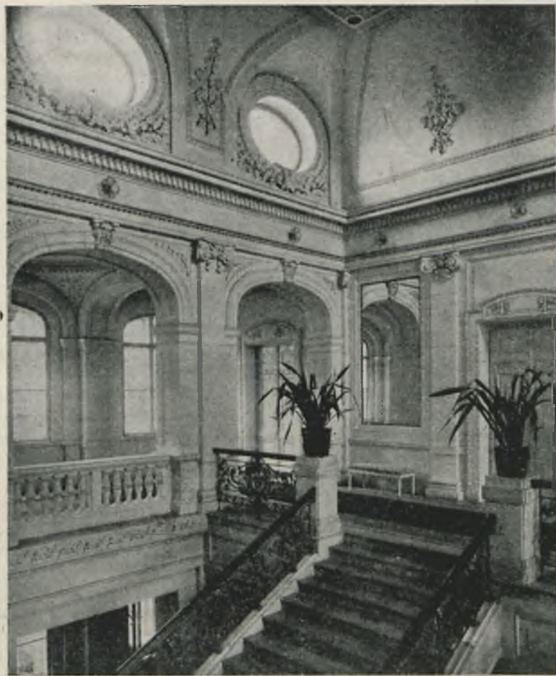
Klatka schodowa gmachu Stow. Techn. Polskich w Warszawie.
