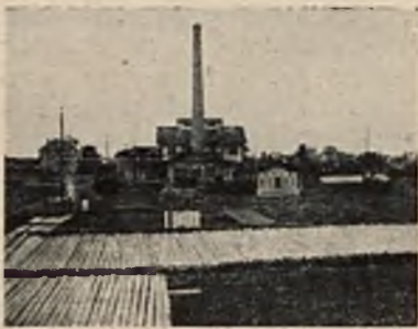
RYC. 13. ZAKŁAD IMPREGACYJNY NASYCANIE SYSTEMAMI KOTŁOWYMI]
