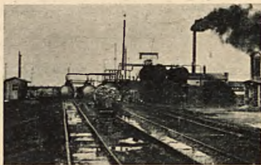
RYS. 16. ZAKŁAD IMPREGNACYJNY P.Z.I. W MOŁODECZNIU.
