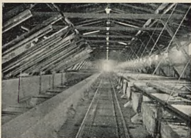
RYS. 9. WNĘTRZE POMIESZCZENIA Z KADZIAMI W DUŻYM ZAKŁADZIE IMPREGN. W/G SYST. KYANA
