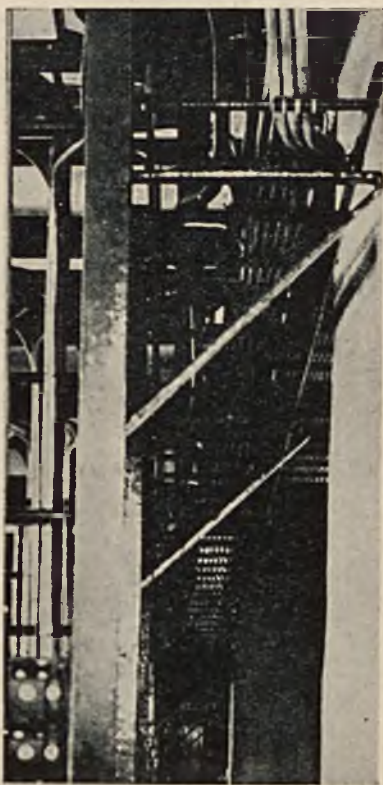
RYS. 82. DRABINKA NA WYSIĘGNIKACH Z BOKU STOJAKÓW.
