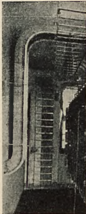
RYŚ. 86. DRABINKA ZEJŚCIOWA DO ŁĄCZNIC RĘCZNYCH.
