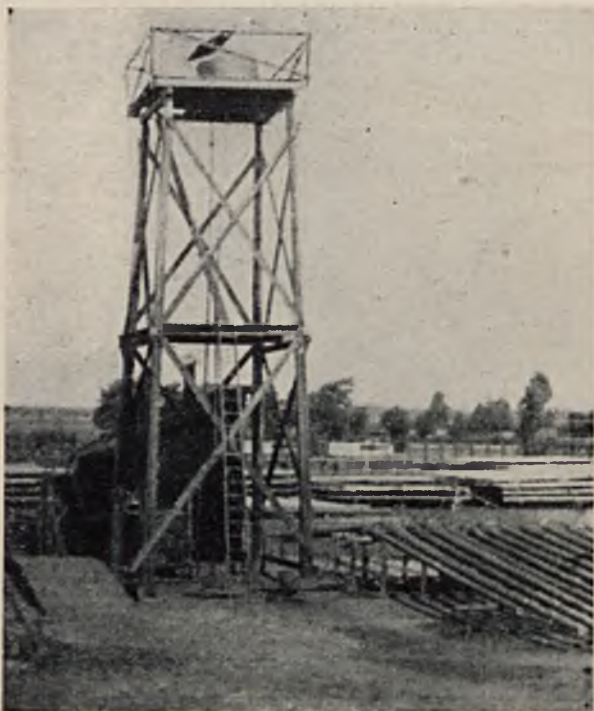
RYS. 6. NASYCALNIA SYST. „BOUCHÉRIE”.
